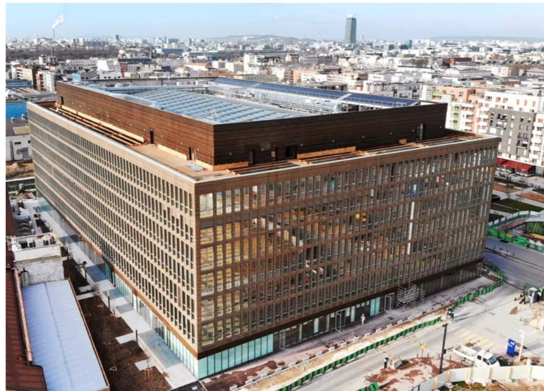
x Livré en janvier 2019, le projet Pulse à Saint-Denis a fait largement appel à des matériaux de réemploi, notamment près de 22000 m<sup>2</sup> de dalles de faux-plancher récupérées sur d'autres chantiers, c'est-à-dire 95% de la surface du bâtiment.
