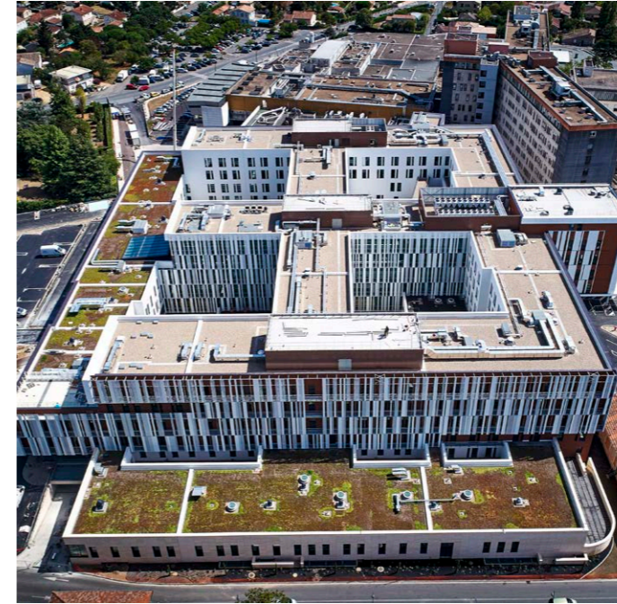
Le groupement conduit par GTM Bâtiment Aquitaine a livré, en 2017, un ensemble de 42 000 m 2 sur six étages. Cet équipement compact, flexible et évolutif a une capacité de 477 lits et 33 places d'hôpital de jour, et comprend 60 salles de consultation.
