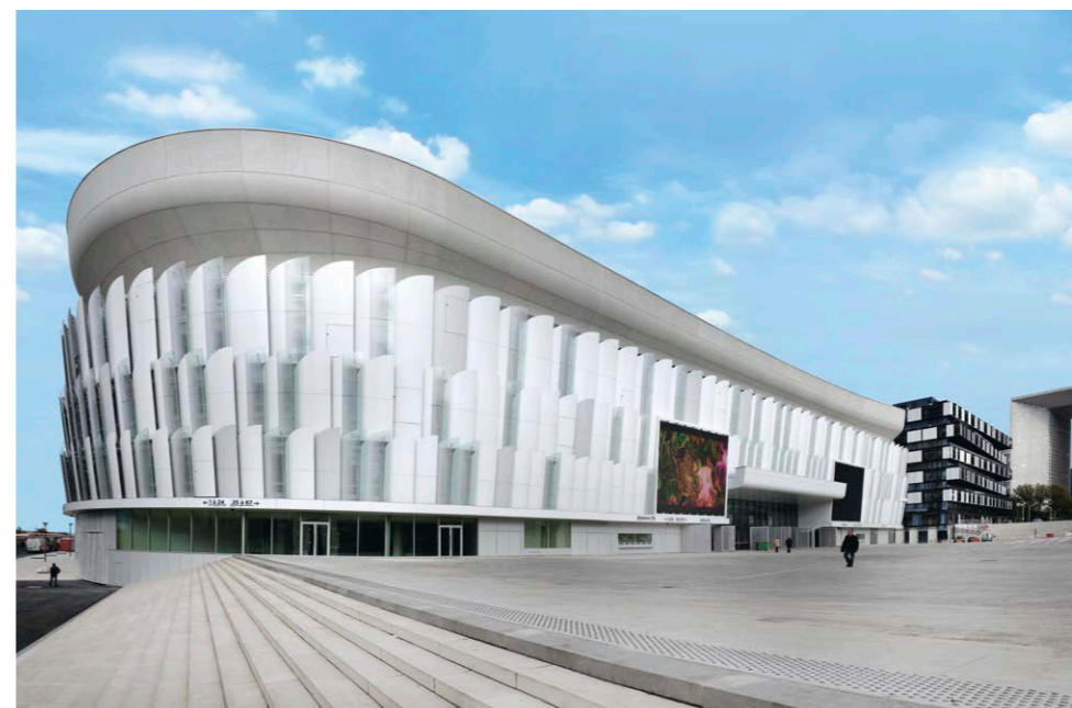
L'enveloppe de la U Arena se compose de trois niveaux d'écaillés blanches et transparentes et de 654 panneaux en béton blanc préfabriqués rappelant la forme des gradins intérieurs. Le projet comprend également des commerces et 30 000 m 2 de bureaux, dont le siège du conseil départemental des Hauts-de-Seine.
