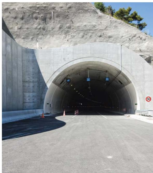
Ce vaste projet comprenait également le soutènement de la voûte avec 5 000 m<sup>3</sup> de béton projeté et 16 500 m<sup>2</sup> de béton de revêtement, 17 000 m linéaires de boulons d'ancrage ainsi que le revêtement de la chaussée avec 7 000 t d'enrobés, coulés par les équipes d'Eurovia.
