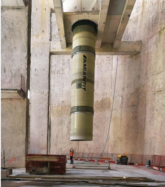
En cas de fortes crues, jusqu'à 14 m<sup>3</sup> d'effluents par seconde, acheminés par un tunnel long de 300 m, pourront se déverser dans le bassin. En sortie, une canalisation de 600 m de longueur les conduira pour traitement vers la station d'épuration Géolide.
