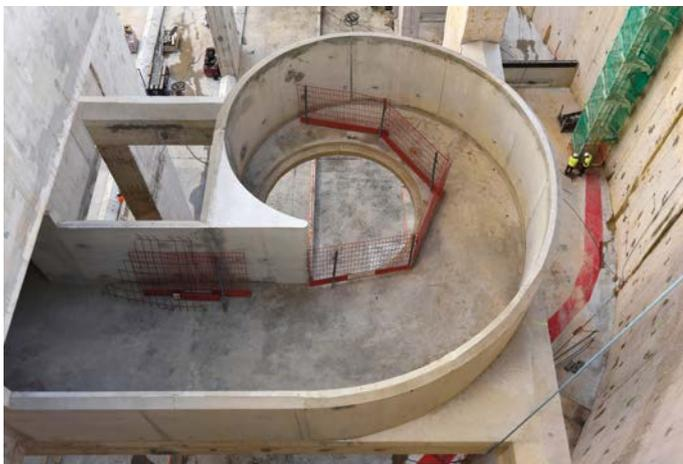
Les 50 000 m<sup>3</sup> d'eaux usées transiteront par un puits à vortex cylindrique, qui permet au flux d'eau de se déverser en mouvement tourbillonnaire. Cette innovation, signée Chantiers Modernes Sud et Campenon Bernard Sud-Est, réduit les émissions de gaz (hydrogène sulfuré), nocives pour les hommes et agressives pour les structures.
