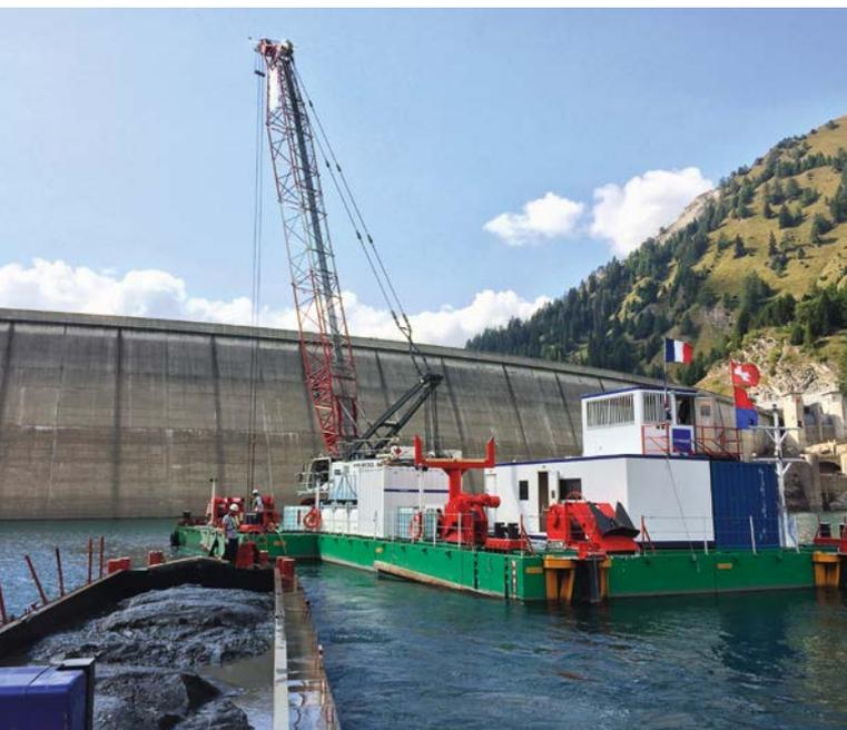
Tournaud a investi dans du matériel conçu spécifiquement pour l'opération, dont deux nouvelles barges à clapet de 80 m<sup>3</sup>, une plateforme de 18 m x 30 m et une benne "environnementale" de 10 m<sup>3</sup>. Un investissement matériel global de plus de 3 millions d'euros, qui permet de draguer 600 m<sup>3</sup> chaque jour.
