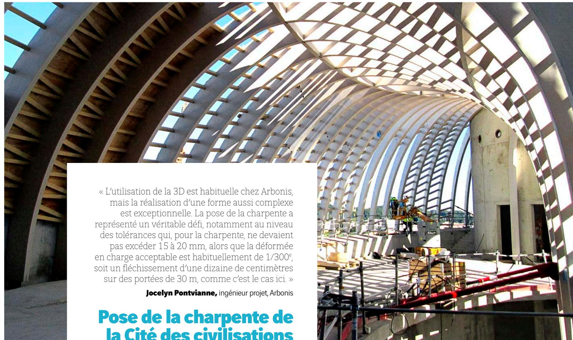
« L'utilisation de la 3D est habituelle chez Arbonis, mais la réalisation d'une forme aussi complexe est exceptionnelle. La pose de la charpente a représenté un véritable défi, notamment au niveau des tolérances qui, pour la charpente, ne devaient pas excéder 15 à 20 mm, alors que la déformée en charge acceptable est habituellement de  $1/300^{\circ}$ , soit un fléchissement d'une dizaine de centimètres sur des portées de 30 m, comme c'est le cas ici. »
