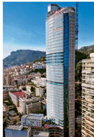
Après son intégration en 2011, le bureau d'études SIDF a réalisé les études de la tour Odéon (Monaco) avec le bureau d'études techniques de VINCI Construction France.
