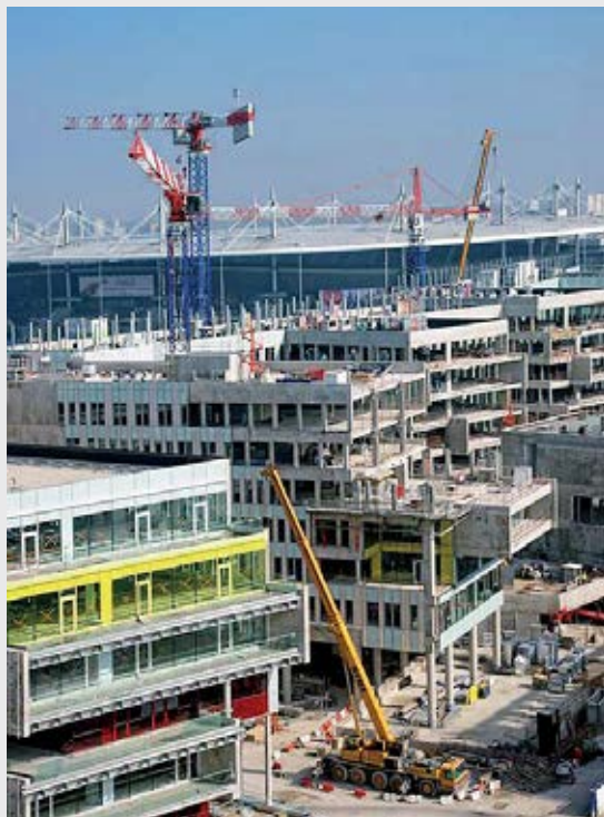
Après la fin du gros œuvre de la première tranche du campus SFR , la seconde devra être livrée en août 2015.
