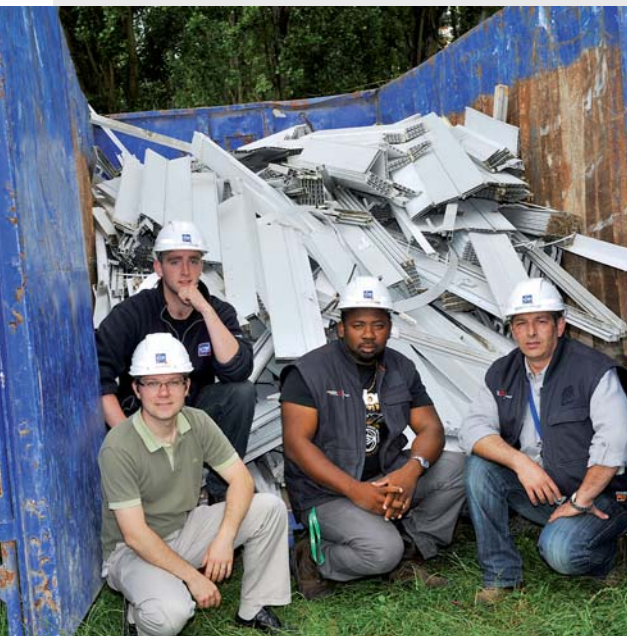
Revalo, la démarche de GTM Bâtiment pour limiter la production de déchets et mieux les recycler, a été labellisée par l'Ademe en 2012.
