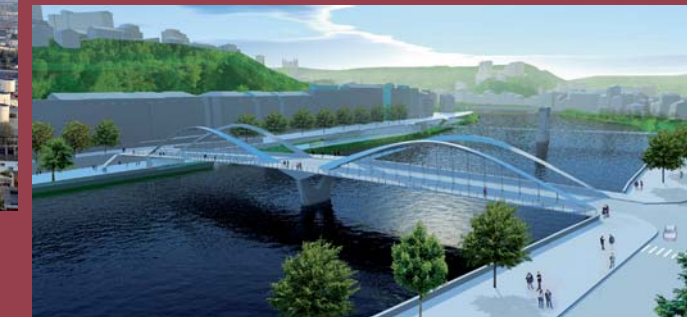
Le pont Schuman , 14 e pont sur la Saône, à Lyon, est un pont en arc composé de deux travées de 84 m et d'un belvédère en partie centrale.
