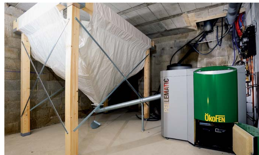
À Villeurbanne (Rhône), Oreha a doté un ancien atelier professionnel d'une extension de 25 m 2 en structure bois et transformé le bâtiment en loft à faible consommation énergétique (installation d'une chaudière à granulés bois, et plancher chauffant).
