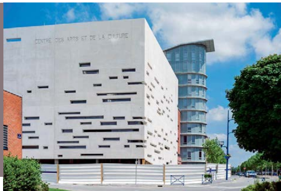
Conçu comme le Mucem par l'architecte Rudy Ricciotti, le Centre des arts et de la culture de Douchy-les-Mines (Nord) met lui aussi en valeur les ressources expressives du béton. En particulier pour les façades, dont le béton blanc a été mis en œuvre sur grande hauteur pour éviter les reprises de bétonnage.
