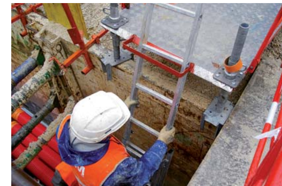
L'accès au point de descente est sécurisé par la garde-corps, la plate-forme est immobilisée dans sa position grâce aux fourches d'étaie bloquées en partie supérieure du blindage. Le système de rattachement de l'échelle interdit tout basculement latéral ou renversement.
