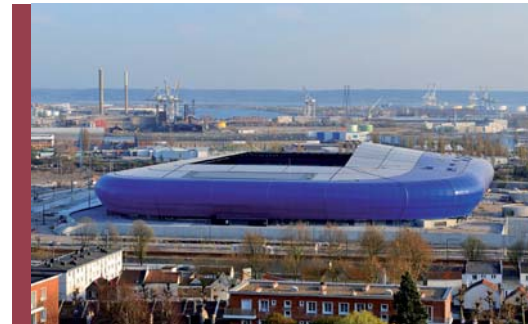
Grâce aux 1 500 m 2 de capteurs photovoltaïques implantés sur sa toiture, le Grand Stade du Havre produit plus d'électricité qu'il n'en consomme.
