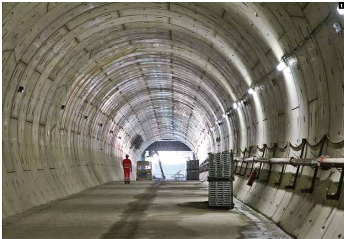
1 Après un parcours de 1 440 m sous le Rhône et l'A7, qui a duré 6 mois, le tunnelier Agathe a achevé en mars 2011, à Oullins, le percement du prolongement de la ligne B du métro de Lyon .
