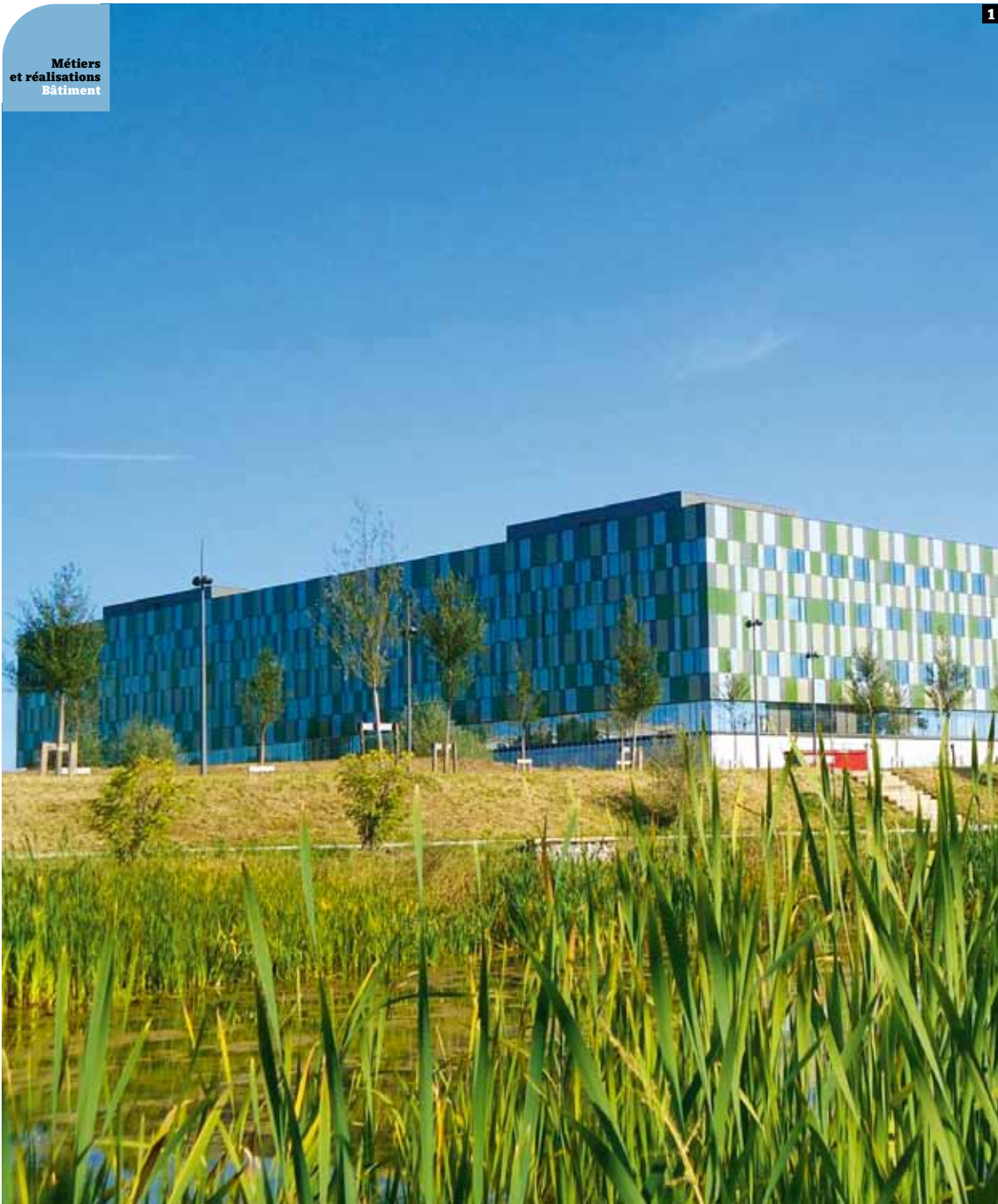
1 VINCI Construction France a réalisé en macro-lot (fondations spéciales, structures, charpente métallique, clos et couvert, second œuvre et finitions) le centre hospitalier William Morey , ex-hôpital du Chalonnais. L'établissement a ouvert ses portes en octobre 2011. Avec 9 pôles médicaux techniques et une capacité d'accueil de 538 lits, 8 salles d'opération, 6 salles d'accouchement, etc., il sera le principal établissement du territoire nord de la Saône-et-Loire.
