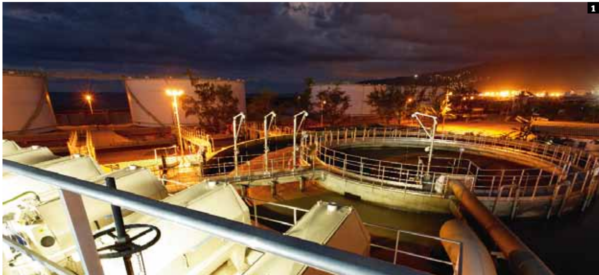
1 Le procédé membranaire R-MeS de VINCI Environnement a été mis en œuvre pour la première fois à La Réunion à l’occasion des travaux d’extension réhabilitation de la Step du Port et de La Possession . Ce système compact permet notamment de réutiliser les eaux traitées en irrigation.
