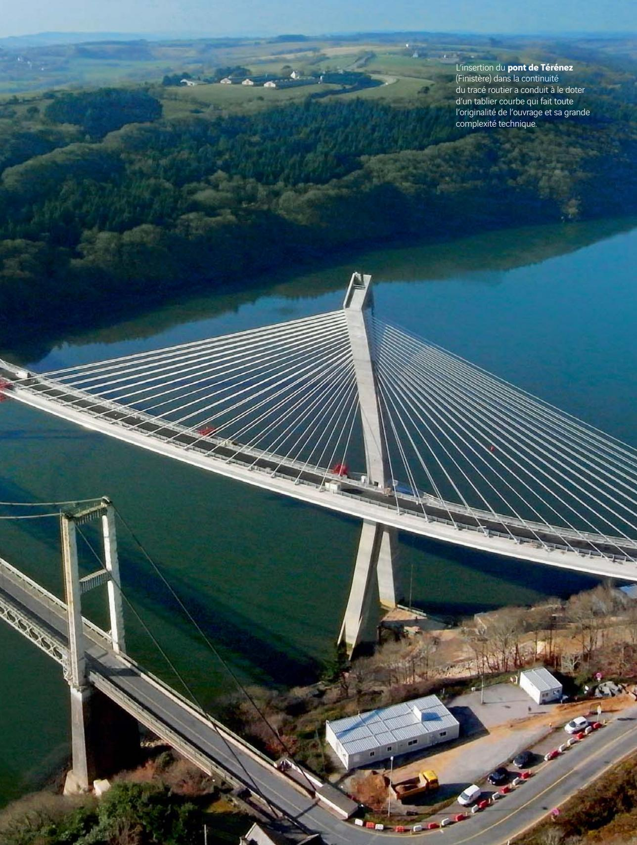
L'insertion du **pont de Térénez** (Finistère) dans la continuité du tracé routier a conduit à le doter d'un tablier courbe qui fait toute l'originalité de l'ouvrage et sa grande complexité technique.
