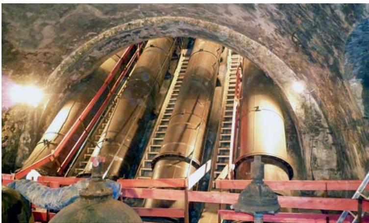
Sous le tablier du **PONT DE COLOMBES** (Hauts-de-Seine), quatre conduites d'assainissement en acier riveté (diamètre 1 100 mm sur 240 m de longueur), qui n'étaient plus étanches, ont fait l'objet d'une campagne de réhabilitation par tubage. L'exiguïté des accès, au niveau des culées du pont, a imposé la mise en place d'un platelage amovible permettant de hisser sur 4,50 m les conduites de tubage, d'un diamètre extérieur de 940 mm et d'une longueur de 3 m.
