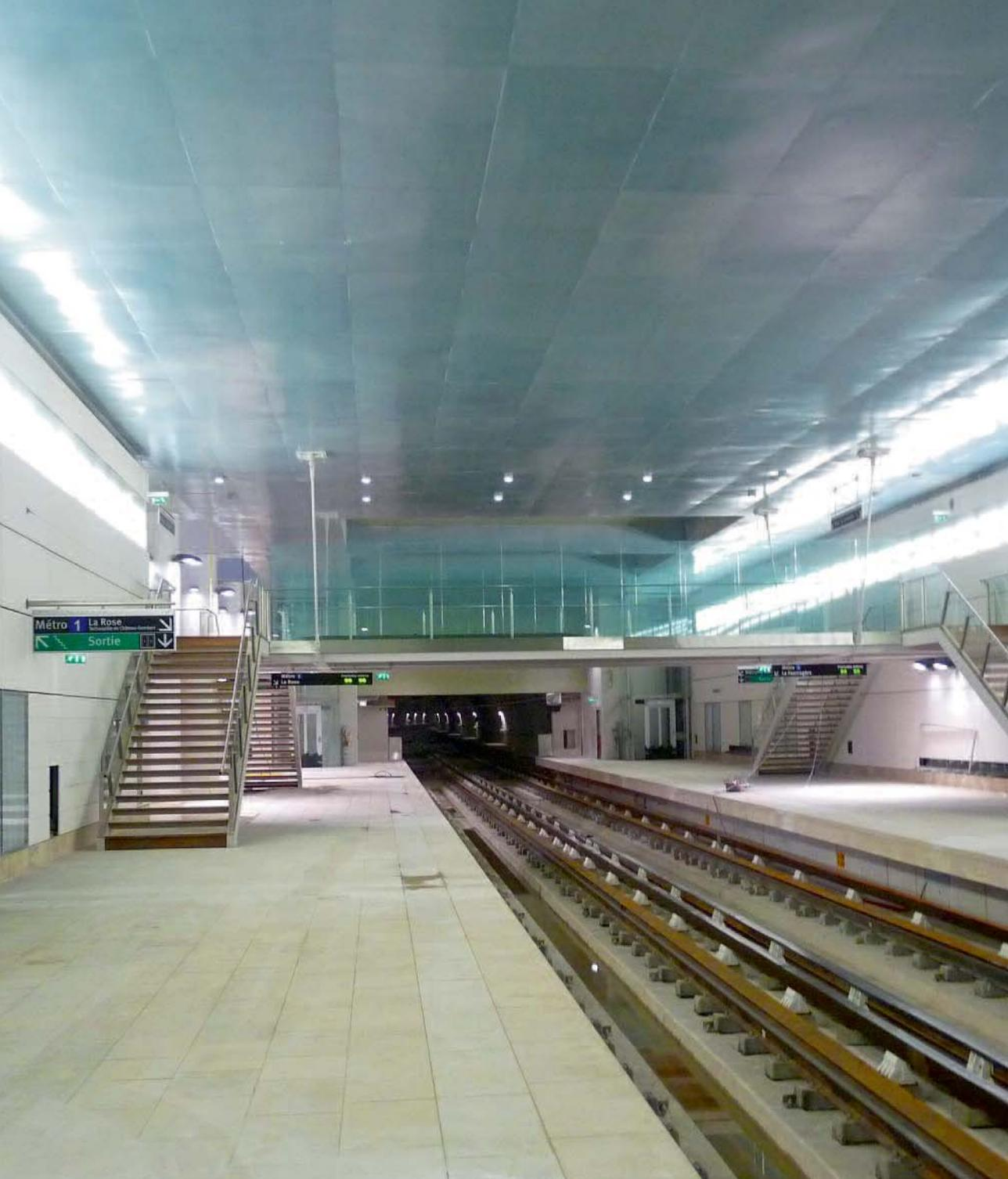
**Métro de Marseille.** Le prolongement de la ligne 1 du métro de Marseille relie la station La Timone au quartier de la Fourragère, dans l'est de la ville. Réalisé à partir de 2005 par un groupement VINCI Construction France, le tunnel, de 9,790 m de diamètre au creusement, est le premier qui a été réalisé au tunnelier dans la cité phocéenne. Long de 1 973 m, il traverse trois stations : La Blancarde, Louis Armand, Saint-Barnabé. La nouvelle section sera mise en service au printemps 2010
