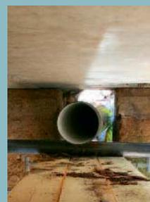
**Les travaux de renouvellement** de 1 400 ml du feeder acier eau potable diamètre 600 mm sur la commune de Roquebrune - Cap-Martin (Alpes-Maritimes) ont été réalisés par les équipes de l'agence hydraulique Sogea-Sud Est d'Èze.
