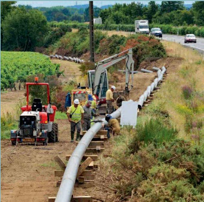
**Réseau gaz.** Dans l'agglomération nantaise, GRDF a confié à EGC Canalisation la réalisation de 8,2 km de canalisation de gaz en acier de 300 mm pour assurer la desserte de La Chapelle-Heulin.
