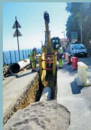
**Cardaillac réalise le renforcement du réseau eau potable** de la commune de Saint-Tropez, liaison AEP entre le réservoir de Bestagne à Gassin et le réservoir Belle Isnarde à Saint-Tropez, 3 900 ml de conduite fonte DN 500 réalisés principalement en site naturel et résidentiel.
