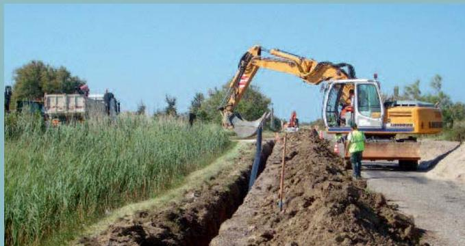
**Dans le cadre de l'extension du réseau d'eau potable de la commune d'Arles (Bouches-du-Rhône),** Sogea Sud-Est TP (agence Hydraulique Provence) a mis en place 26 400 ml de canalisations en PEHD.
