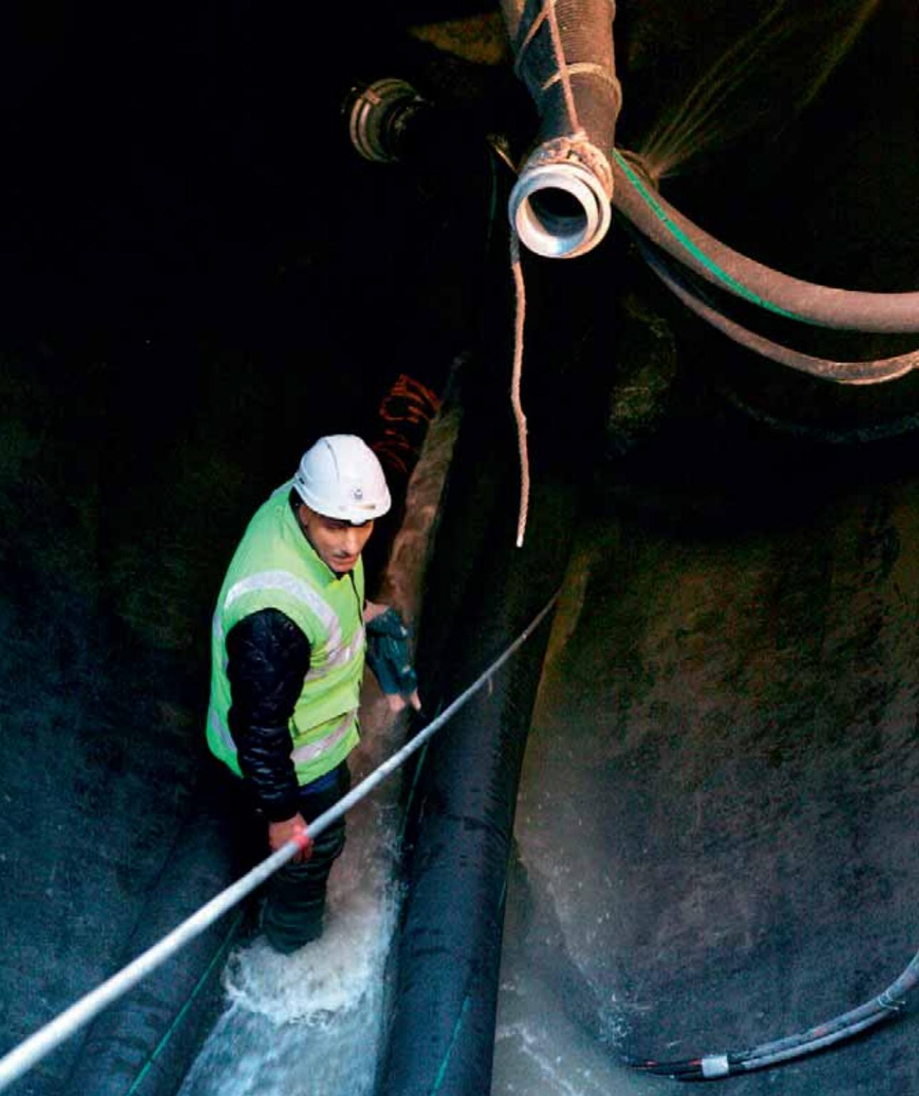
**Émissaire de Rueil.** Sobeia Environnement (génie civil) et les plongeurs de CTS (curage du siphon sous la Seine) ont mis en chantier la réhabilitation de l'émissaire de Rueil, un ouvrage construit il y a 50 ans pour acheminer une partie des eaux usées de Paris vers l'usine du Siaap Seine-Aval, à Achères.
