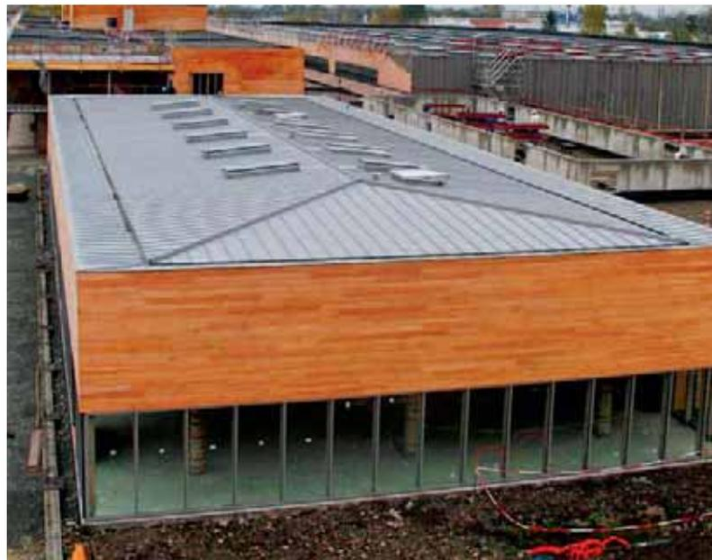
**Le bardage en pin douglas des façades du lycée des métiers du bâtiment de Riom (Puy-de-Dôme)** n'est que la partie visible de la « solution bois globale » proposée par Arbonis pour cet ouvrage. En toiture a par exemple été mis en place en variante un système novateur de « caissons » préfabriqués dans les ateliers de Satob Construction Bois et livrés prêts à poser sur le chantier.
