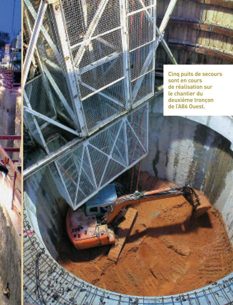
Cinq puits de secours sont en cours de réalisation sur le chantier du deuxième tronçon de l'A86 Ouest.
