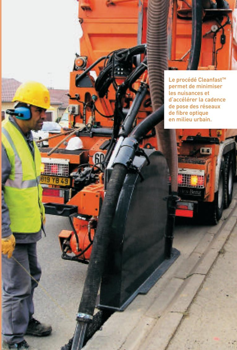
Le procédé Cleanfast™ permet de minimiser les nuisances et d'accélérer la cadence de pose des réseaux de fibre optique en milieu urbain.
