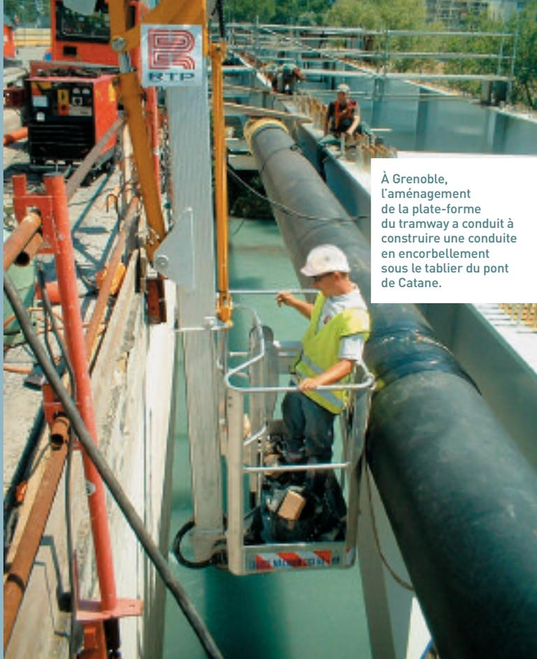
À Grenoble, l'aménagement de la plate-forme du tramway a conduit à construire une conduite en encorbellement sous le tablier du pont de Catane.
