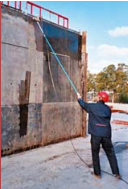
Le rouleau à graisser, conçu par Campenon Bernard Régions, protège l'opérateur des éclaboussures, facilite le graissage et réduit la quantité d'huile utilisée.
