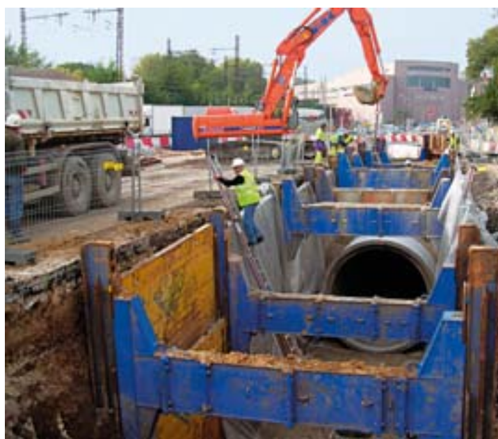
À Montpellier, Sogea Sud a posé le collecteur de chambéry (diamètre 2800), une conduite située en plein centre ville qui demeurera en permanence en charge complète
