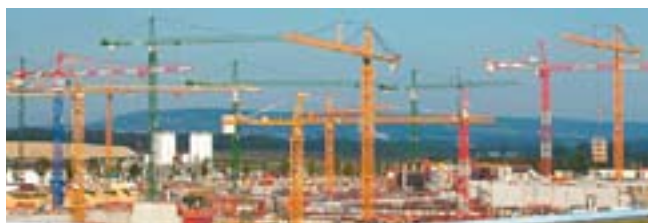
Le chantier évolue au rythme des grues
