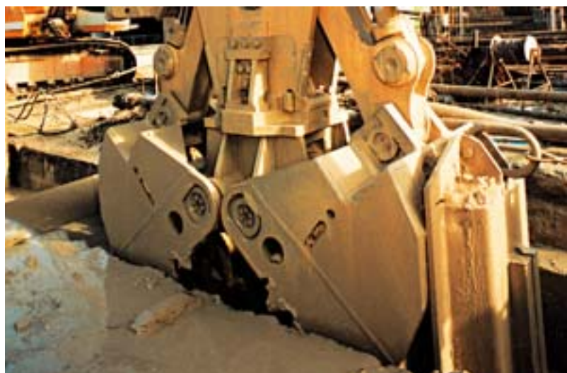
Avec l'acquisition de nouveaux outils, comme le cutter ou la benne hydraulique, Botte Fondations renforce son savoir faire dans les fondations spéciales
