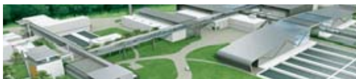
La station d'épuration de Strasbourg illustre les synergies existantes au sein de Sogea Construction. Y travaillent Sogea Est, Urban, la Direction du traitement de l'eau et Speic.
