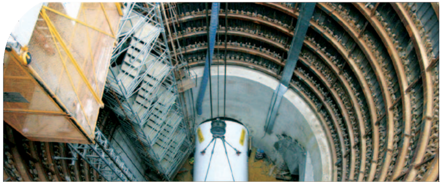
Campanon Bernard TP réalise la galerie de traitement des niches n° 30, 31 et 32 de l'A86 à l'ouest de Paris.
