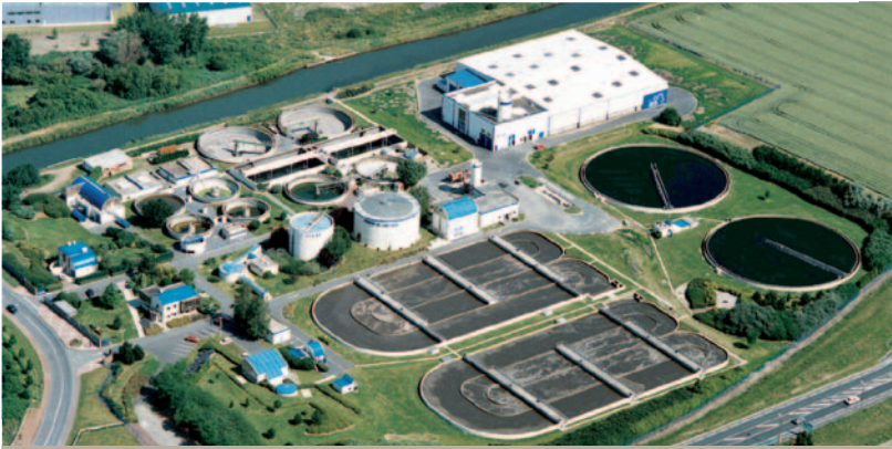
Sogea Nord exploite la station d'épuration de Douai certifiée ISO 14001 en 2004.
