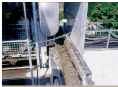
Le pont à béton, équipé de machines dans la réhabilitation de sites aquatiques avec traitement des boues.
