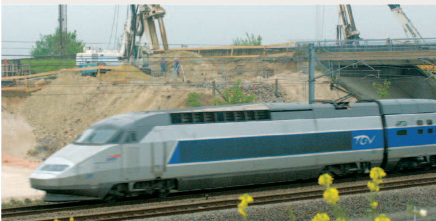
Deschiron, Campenon Bernard TP, Dodin, Muller Génie Civil, Sogea Est et Botte Fondations ont travaillé en synergie pour la réalisation de la ligne TGV entre Paris et Strasbourg.
