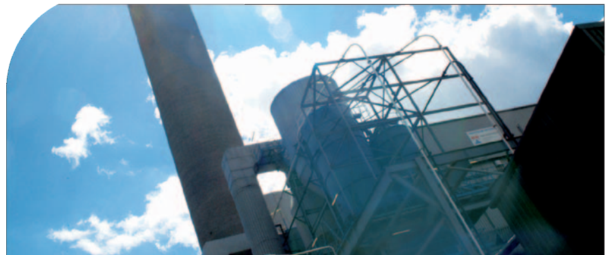
VINCI Environnement réalise les travaux d'amélioration des paramètres de combustion de l'usine London Waste d'Edmonton.
