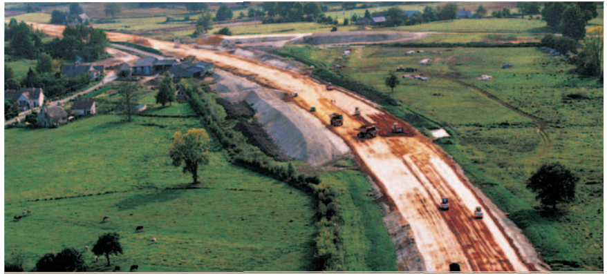
Deschiron assure les travaux de terrassement de l'autoroute A63.
