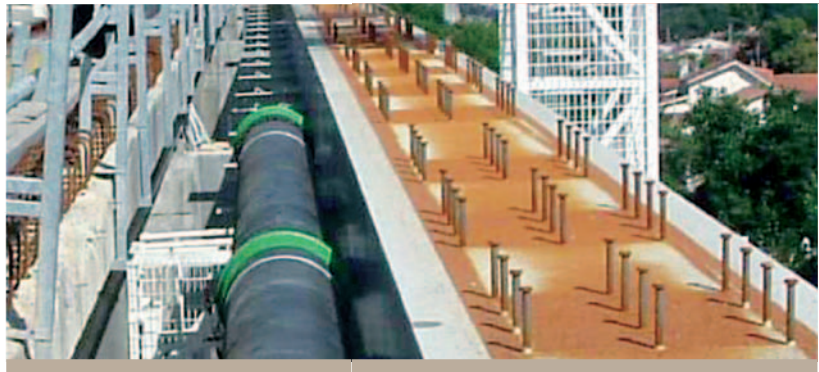
L'élargissement du viaduc d'accès au pont d'Aquitaine à Bordeaux a été confié à Sogea Sud-Ouest Hydraulique (canalisations) et Dodin (génie civil).
