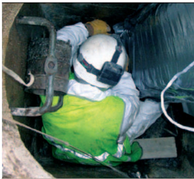
Barriquand accompagne les agences régionales de Sogea dans les travaux de réhabilitation de canalisations et dans les techniques spéciales du sous-vide.
