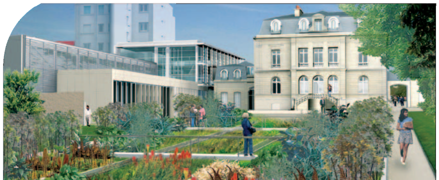
La restructuration de l'hôtel de ville de Sceaux est assurée par Campenon Bernard Construction dans le cadre d'une démarche HQE®.
