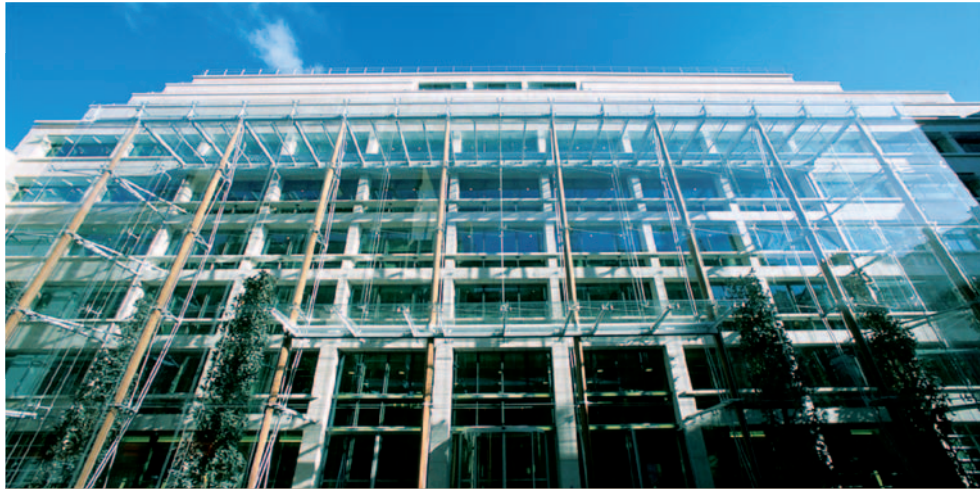
Sicra et Bateg ont réhabilité le siège de Groupama, rue d'Astorg, à Paris.
