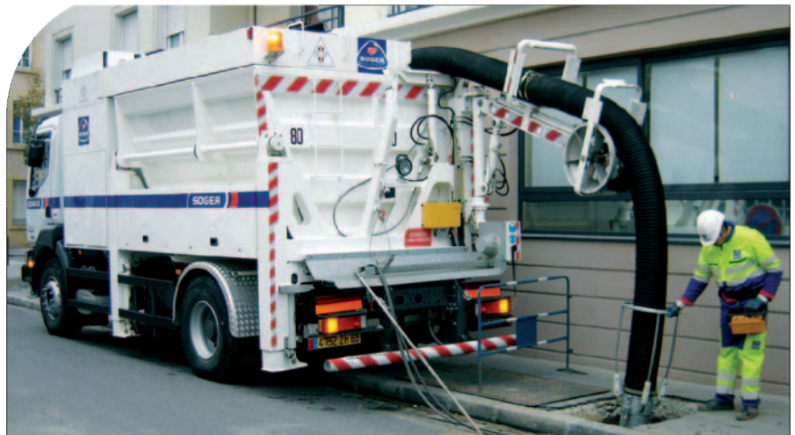
La création d'un camion-aspirateur a permis à Sogea Rhône-Alpes de traiter plus efficacement ses chantiers de renouvellement des branchements en plomb de la région lyonnaise.
