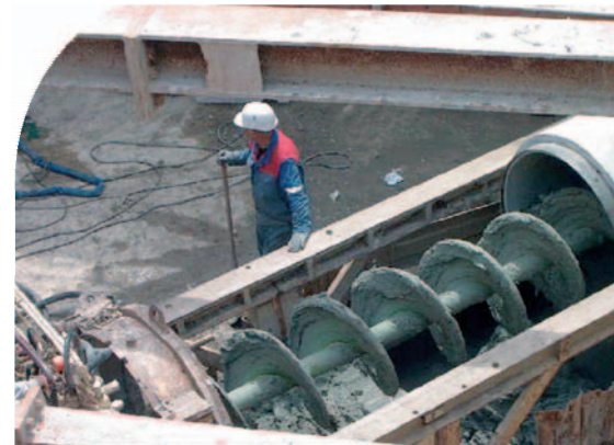
Sogeforh utilise traditionnellement le forage horizontal à la tarière pour le passage de canalisations sans tranchée.
