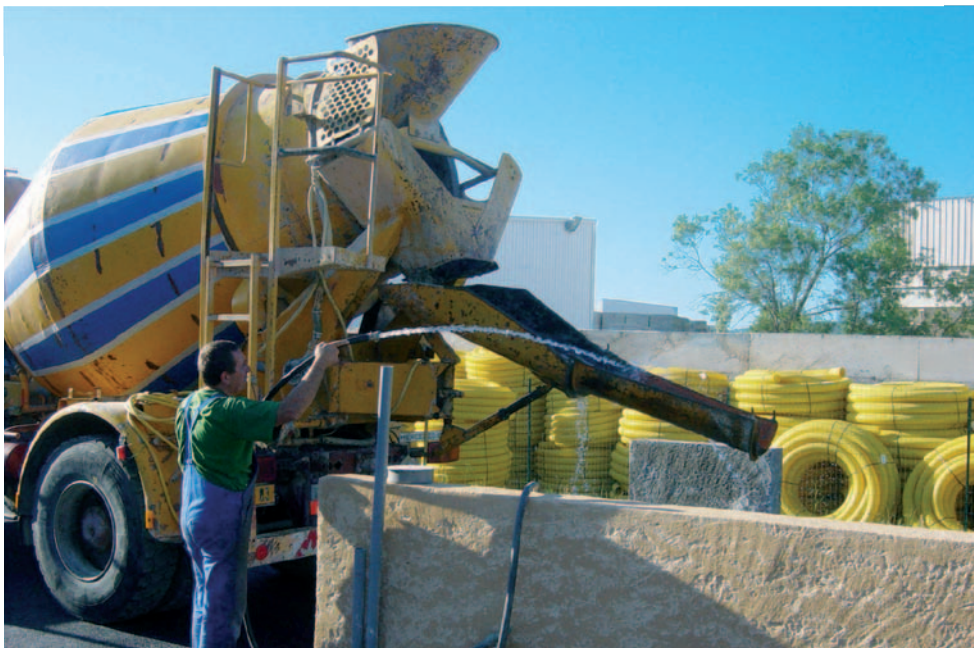
La qualité du service s'illustre par le respect de l'environnement du chantier avec la récupération des eaux de lavage des bennes à béton et le nettoyage des roues des camions avant que le véhicule reparte du chantier.
