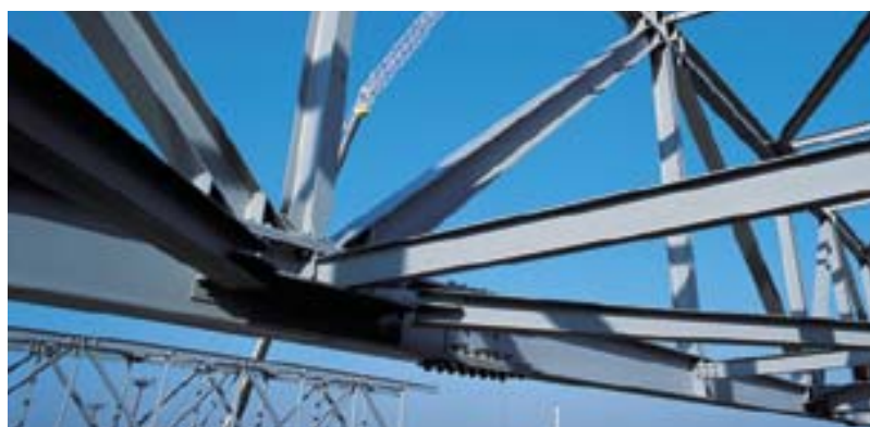
■ La restructuration du Hall Rhénus, à Strasbourg, a été confiée à Urban.
