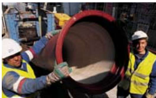
■ À Saint-Étienne, Sogea Rhône-Alpes a posé un réseau d'assainissement en fonte de diamètre 600.
