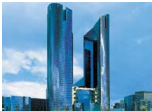
■ Manei assure la maintenance des tours de la Société Générale, à La Défense, construites en 1992 par Sogea Construction.
