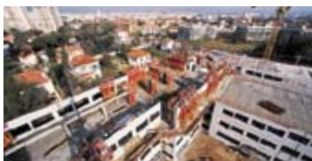
■ Suite à une opération de montage, Campenon Bernard Méditerranée construit des bureaux pour EDF, à Marseille.
