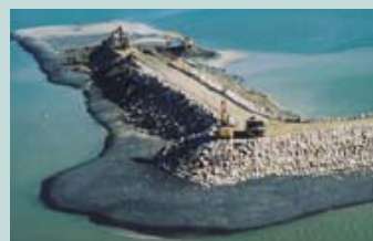
■ Plusieurs filiales de Sogea Construction interviennent sur le chantier Port 2000, au Havre.
