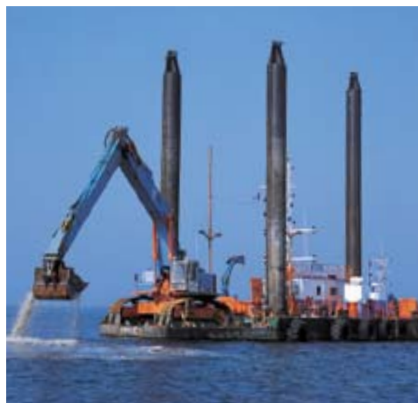
■ L'émissaire de rejet en mer pour la station d'épuration de Dinard a été confié à EMCC.
