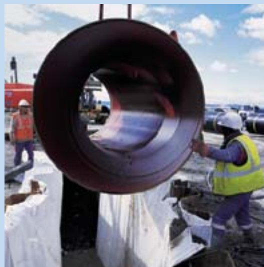
■ La pose en ligne de l'émissaire sur le tronçon lagunaire de La Cereirède a été achevée fin mars 2003 par Sogea Sud.
