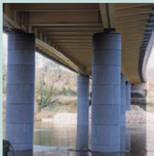
■ Sur l'A20, Dodin a réalisé le viaduc sur le Lot, à Cahors.
