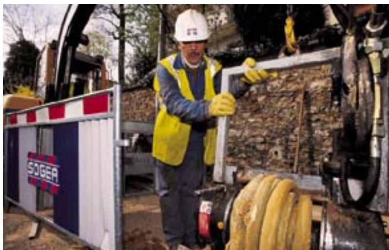
■ Sobeia Environnement remplacera 4 000 branchements en plomb en région parisienne.
