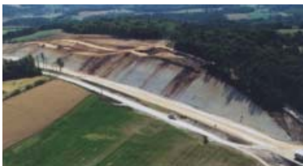
■ Deschiron poursuit les travaux de terrassement sur l'autoroute A89, reliant Bordeaux à Clermont-Ferrand.
