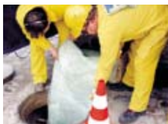
■ Barriquand est spécialisée dans la technique de réhabilitation de canalisations non visitables.
