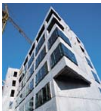
■ Sogea Nord réalise l'opération de bureaux "Euralliance", à Lille.
