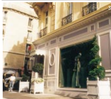
2. Sicra Maintenance Multiservices assure la maintenance multitechnique du siège de la SGE, à Rueil 2000.
