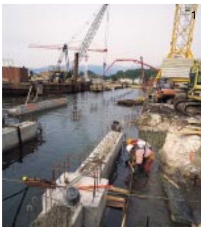
1. Dodin réalise actuellement plusieurs chantiers sur l'Arsenal de Toulon, notamment la construction du futur quai d'accostage du porte-avions Charles-de-Gaulle.
