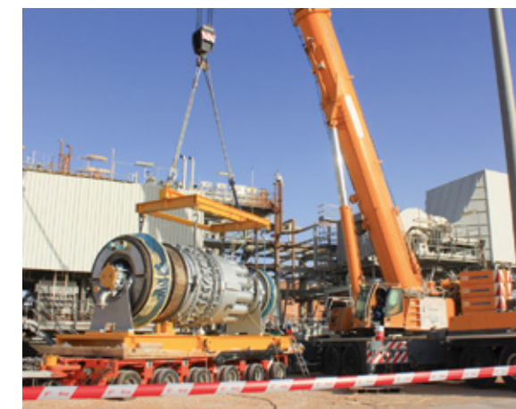
Opération de levage sur le site de MLN
