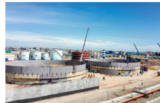
Réservoirs en construction sur le site d'El Eulma
