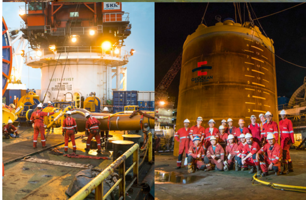
Opération de connexion du riser au plug
