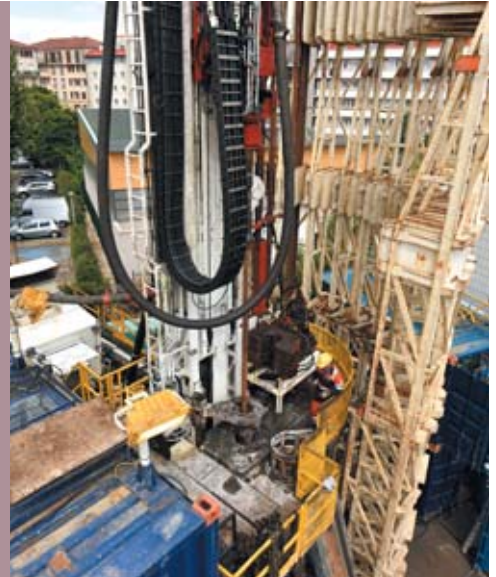
Réalisation d'un puits de géothermie, Chevilly-Larue, France.
