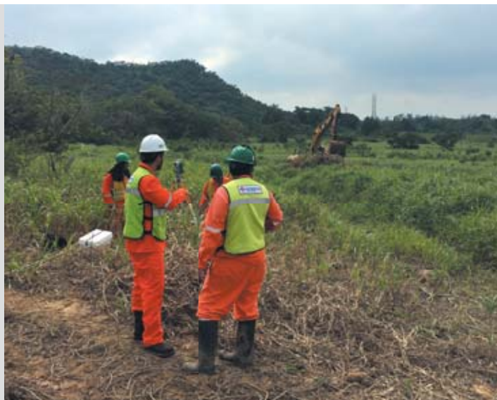
Travaux d'aménagements préparatoires. Projet Shalapa, Mexique.
