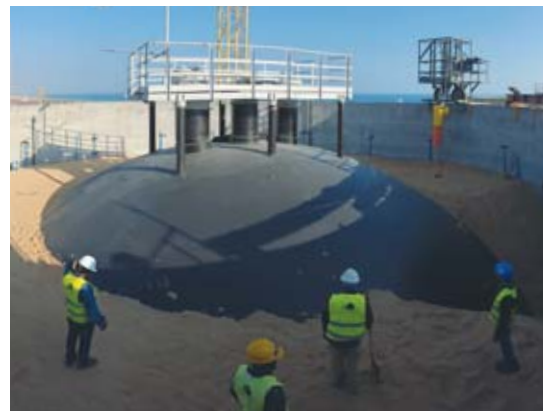
Pour assurer leur protection mécanique, les sphères de stockage sont ensablées. Gabès, Tunisie.
