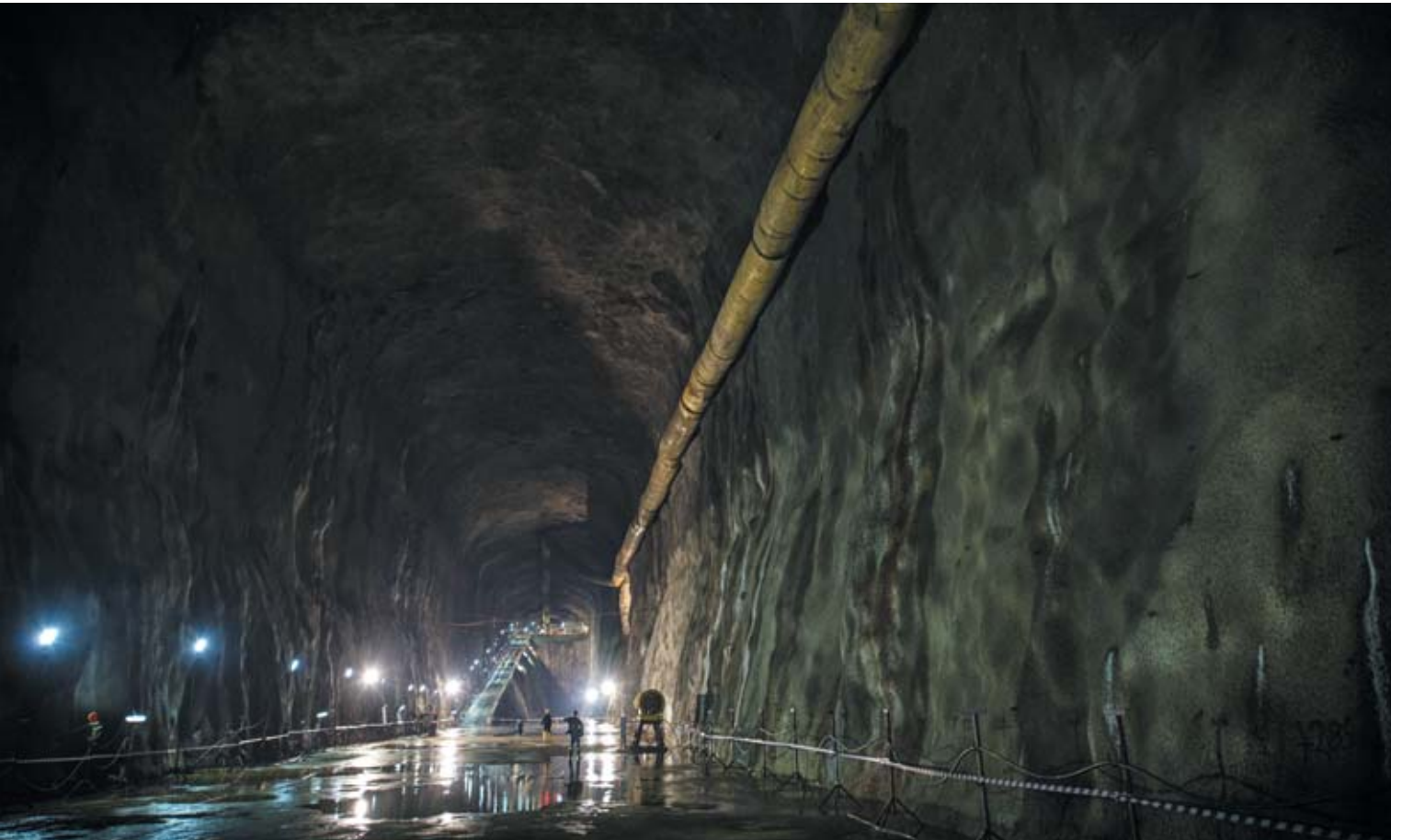
Jurong Rock Cavern, l'un des principaux projets de stockage de Geostock en 2015, Singapour.
