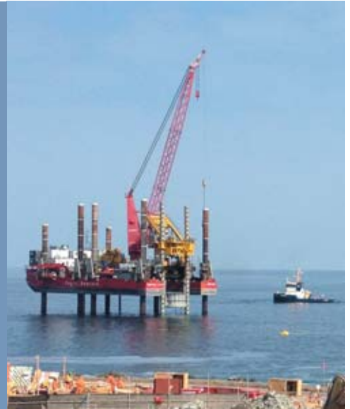
Barge jack-up à Puerto Coloso. Projet Escondida Water Supply (EWS), Chili.
