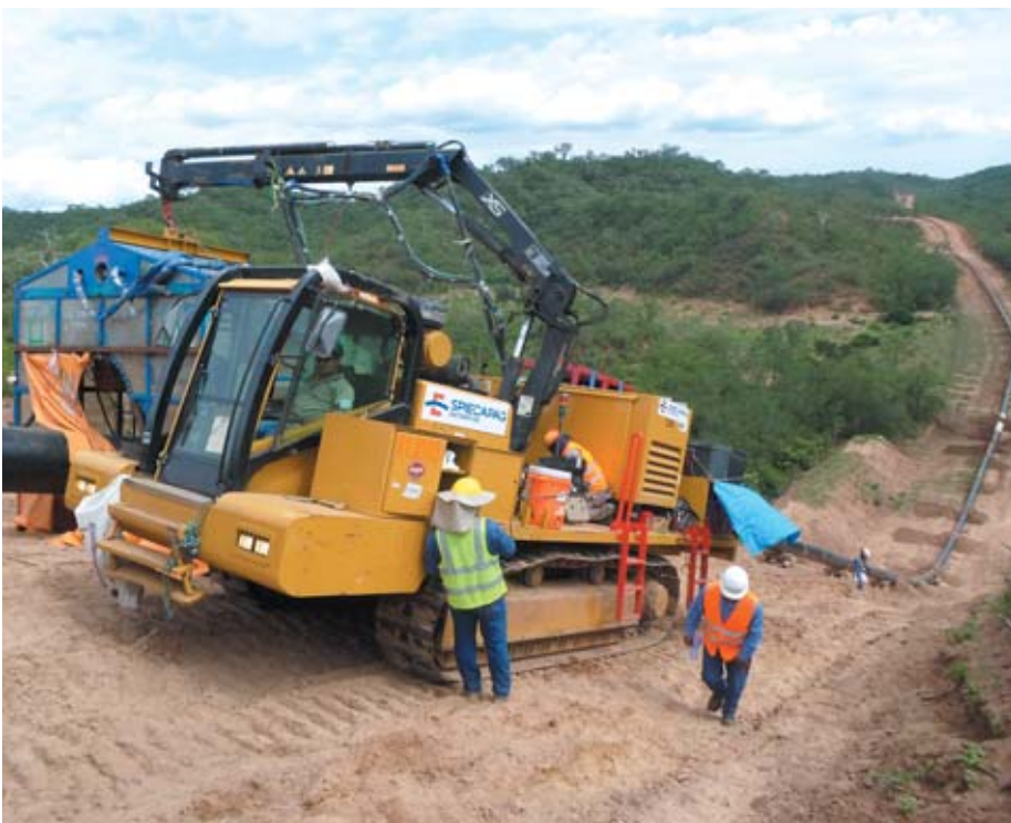
Atelier mobile de soudure. Projet Incahuasi, Bolivie.
