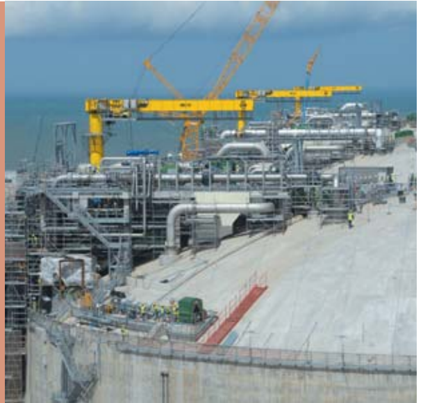
Construction des réservoirs de Dunkerque LNG, France.
