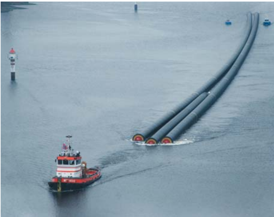
Remorquage de conduites en PEHD. Projet d'émissaire en mer, Maroc.
