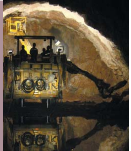
Travaux préparatoires à la mise en exploitation d'un site de stockage souterrain en Chine.
