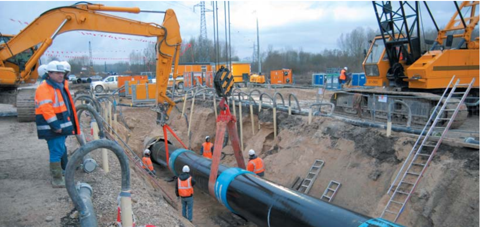
Franchissement de la Seine à Pont-sur-Seine (Aube). Projet Arc de Dierrey, France.
