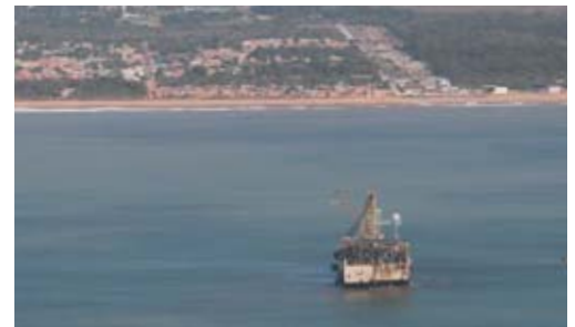
Site d'atterrage du projet Rota Cabiunas, Brésil.
