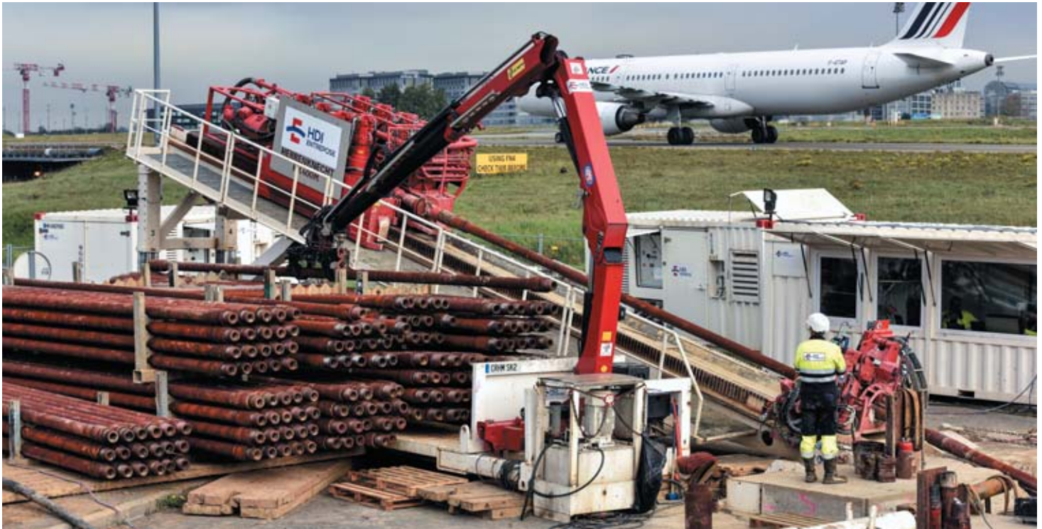
Forage horizontal dirigé sous les pistes de l'aéroport de Paris – Charles-de-Gaulle, France.
