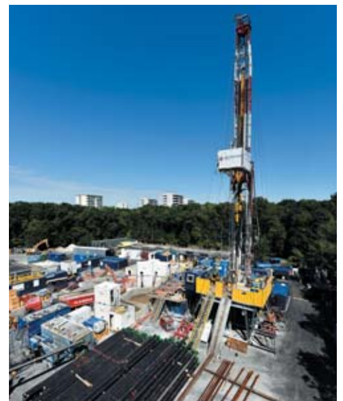
Forage géothermique à Tremblay-en-France, France.
