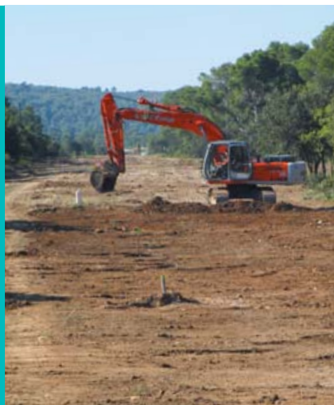
Lors du Challenge santé, sécurité et environnement 2015 d'Entrepose, Geostock a été récompensé pour l'utilisation de repères de pipeline en amidon de maïs.
