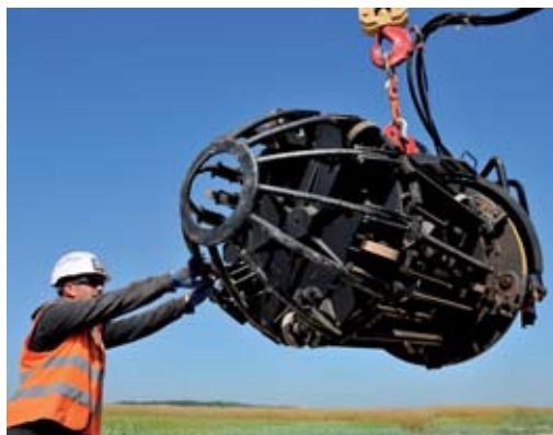
Mise en place d'un clamp sur le projet Arc de Dierrey.
