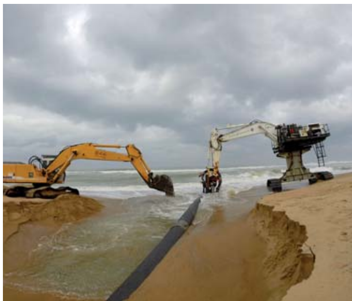
Opération d'ensouillage de conduite au Bénin.
