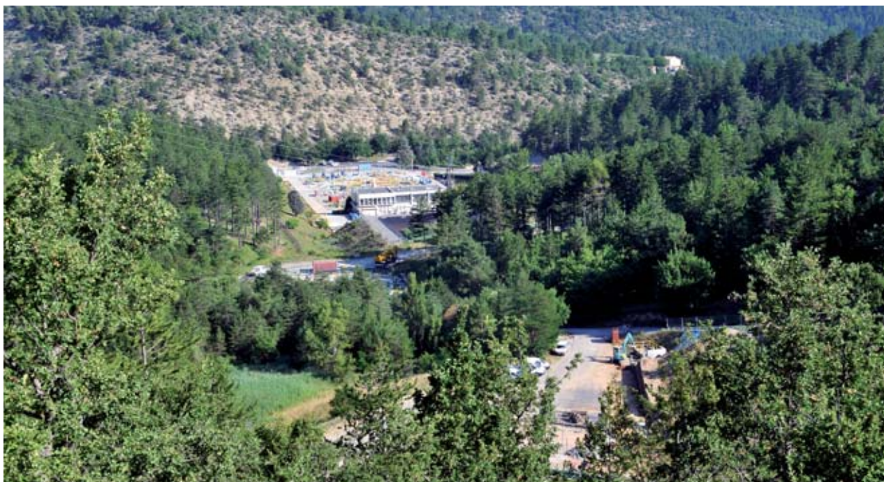
Site de stockage souterrain de Manosque, en France, exploité par Geostock.
