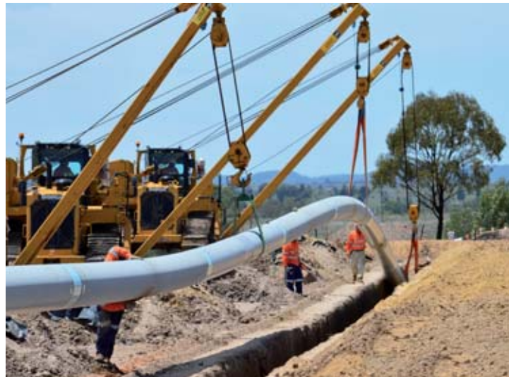
Installation d'un pipeline pour QGC en Australie.
