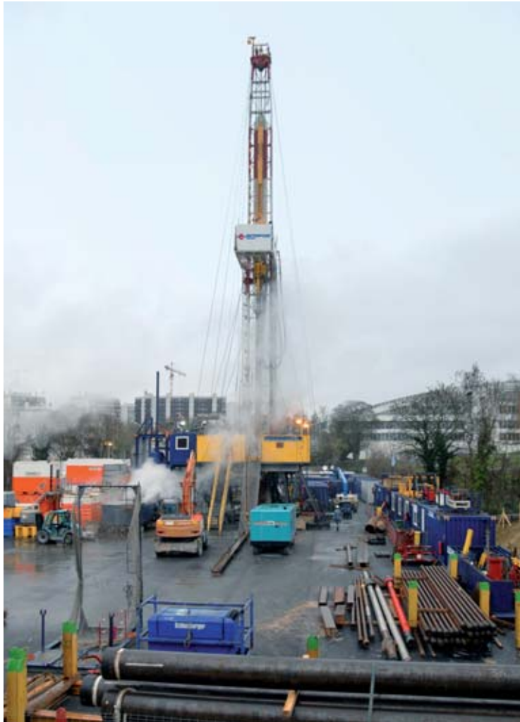
Forage géothermique à Bagneux, France.
