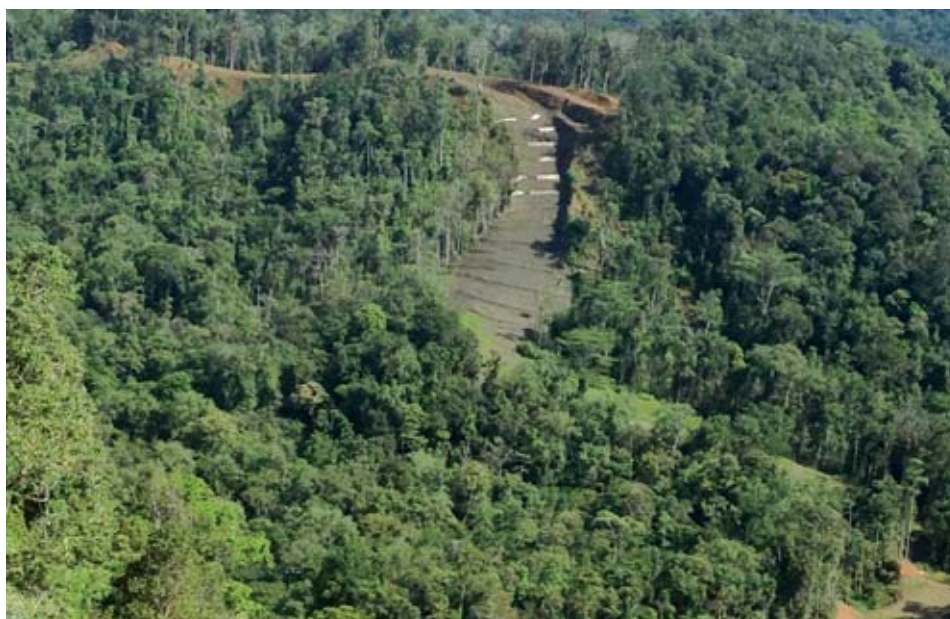
Remise en état du terrain par Spiecapag après intervention – Projet PNG LNG en Papouasie- Nouvelle-Guinée.
