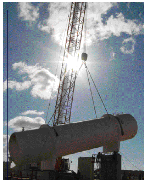
Mise en place d'un SURGE VESSEL-LIBYE SURGE VESSEL installation-LYBIA
