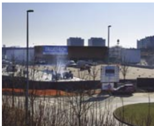
Decathlon s'installe à Anderlecht.
