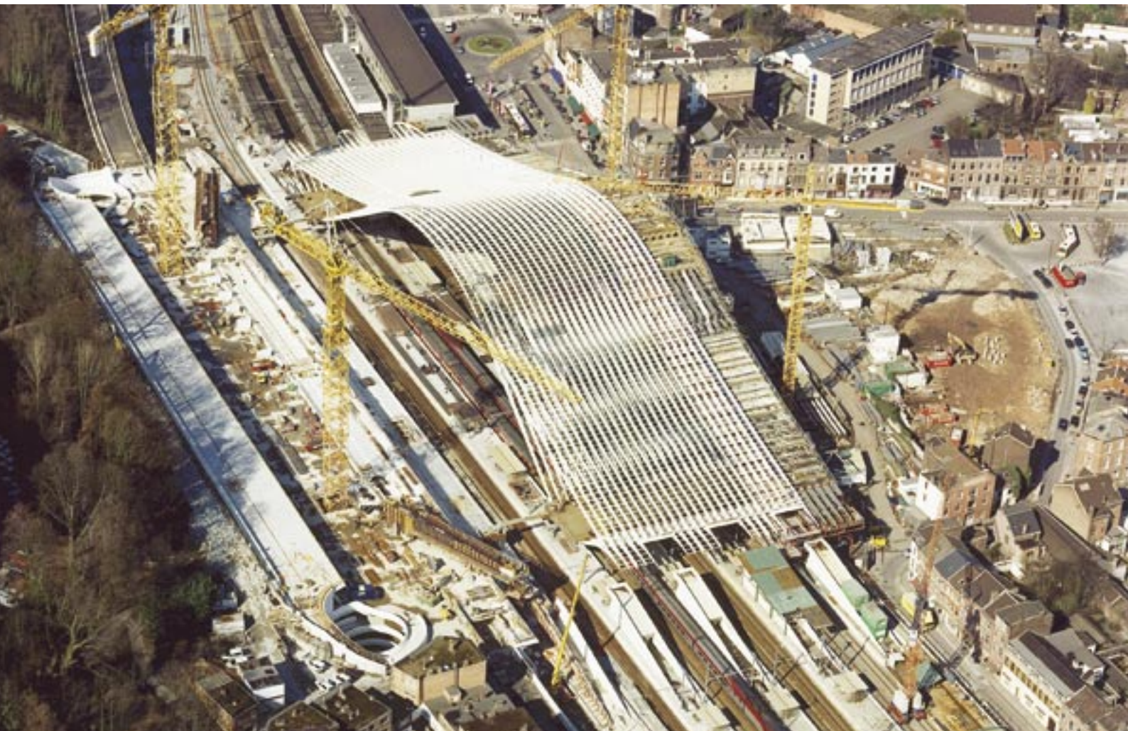
Mise en place de la coupole de la gare des Guillemins à Liège.
