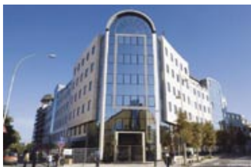
Le complexe du "Dôme" est en phase de parachèvements.
