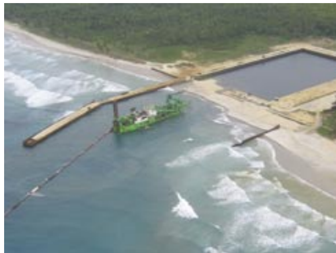
Dragage d'une entrée vers le lagon d'Effasu au Ghana.
