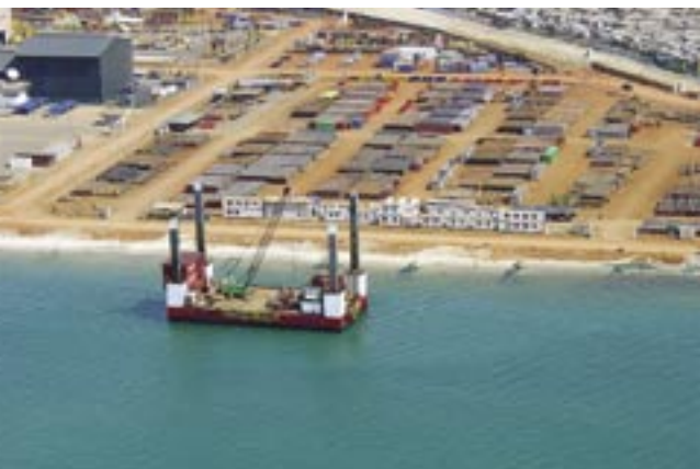
Forage de grands pieux d'ancrage à Luanda en Angola.
