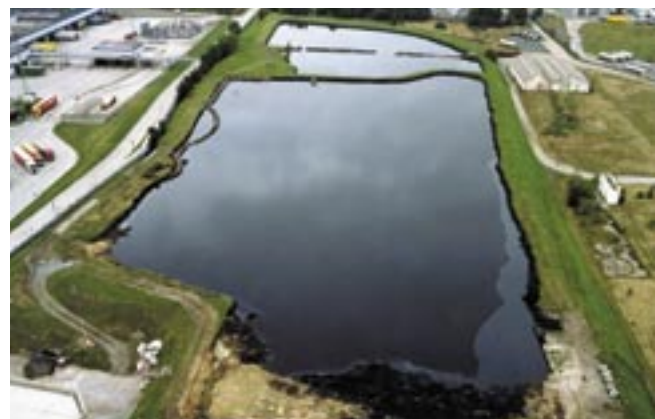
Assainissement de goudron acide à Ertvelde en Belgique.
