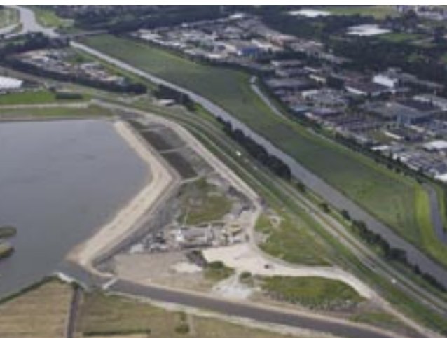
Travaux d'assainissement à Heerhugowaard aux Pays-Bas.
