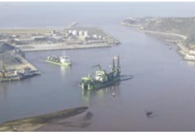
La nouvelle drague suceuse à désagrégateur "d'Artagnan" et la drague porteuse "Antigoon" s'allient pour approfondir le chenal d'accès au port de Avilés en Espagne.
