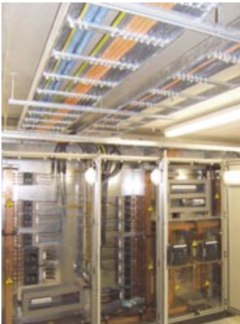
Le tableau général basse tension du centre hospitalier Molière-Longchamp à Bruxelles.
