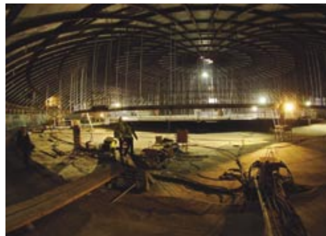
Construction du quatrième réservoir gazier de Fluxys à Zeebrugge.
