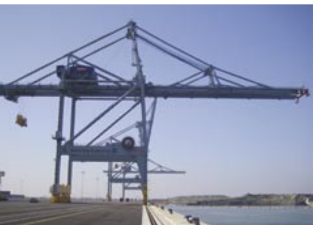
Après le placement des rails et l'asphaltage, les grues peuvent rouler.
