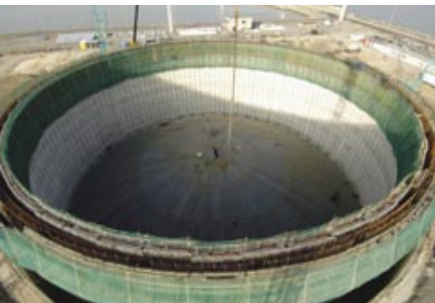
Le quatrième réservoir du terminal gazier de Fluxys à Zeebruges.
