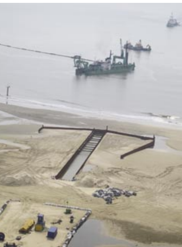
Les dragues "Aquarius" et "Orwell" procèdent aux creusements destinés à l'installation d'un pipeline gazier à l'île de Bonny au Nigéria.
