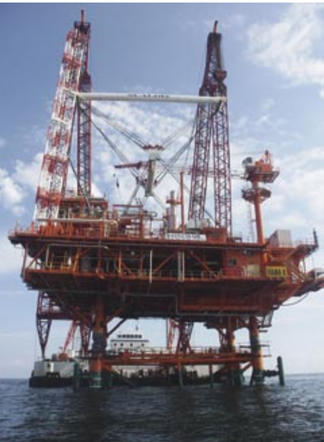
Levage et installation de la plateforme "Ivana K" à Zagreb en Croatie.
