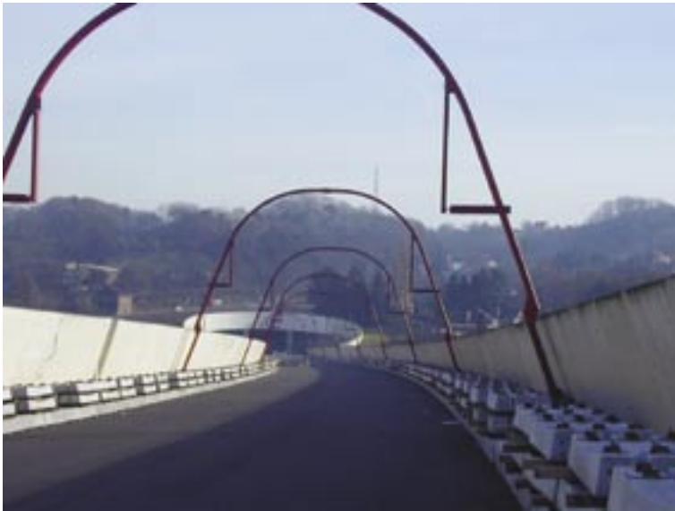
Placement d'arceaux pour l'alimentation électrique de la ligne ferroviaire sur le viaduc surplombant la Vesdre à l'entrée du tunnel de Soumagne.
