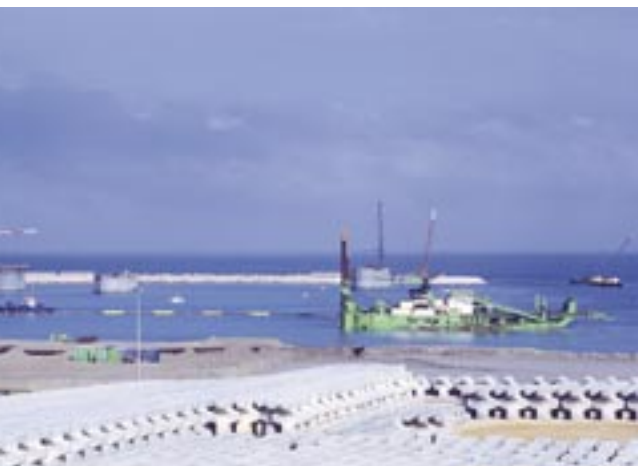
Dragage du nouveau port de Tanger-Méditerranée au Maroc à l'aide du "Vlaanderen XIX".
