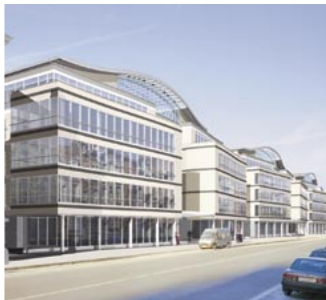
Immeubles de bureaux des "Jardins de la Couronne" à Bruxelles.
