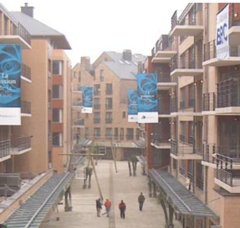
L'ensemble Charlemagne à Louvain-la-Neuve.
