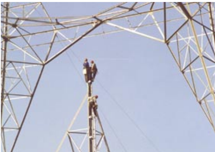
Montage de pylônes haute tension sur le site du "Deurganckdok" à Doel.
