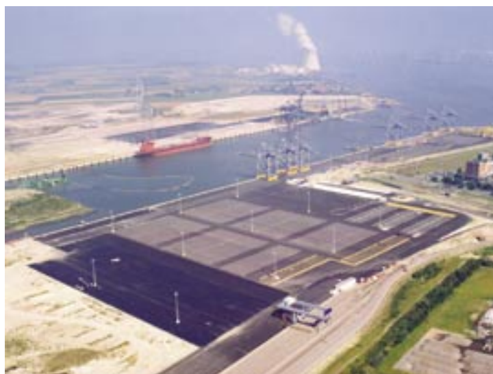
Revêtement des quais du Deurganckdok pour P&O.
