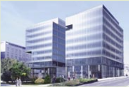
Ouverture d'un premier chantier en Slovaquie.
