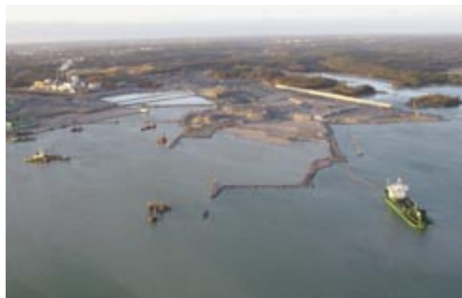
Deuxième phase des travaux de dragage et de remblayage de sable marin pour l'extension du port de Vuosaari en Finlande.
