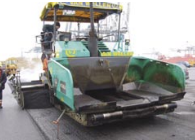
L'asphaltage des routes, un métier enrobé.
