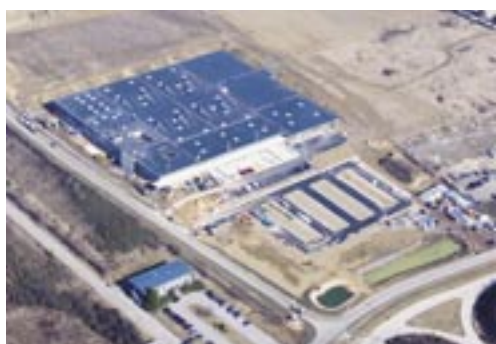
Le centre de tri postal de Bettembourg.
