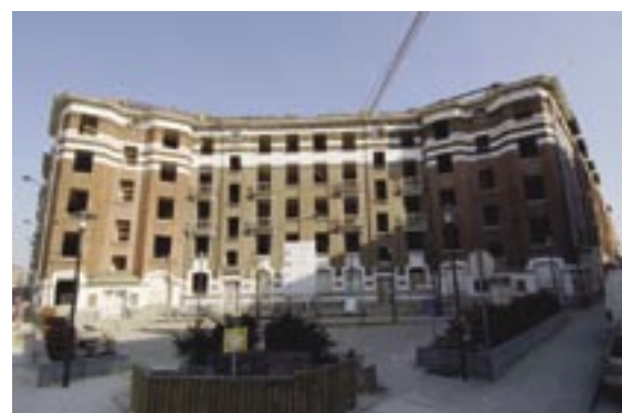
Le Foyer Schaerbeekois en cours de rénovation.
