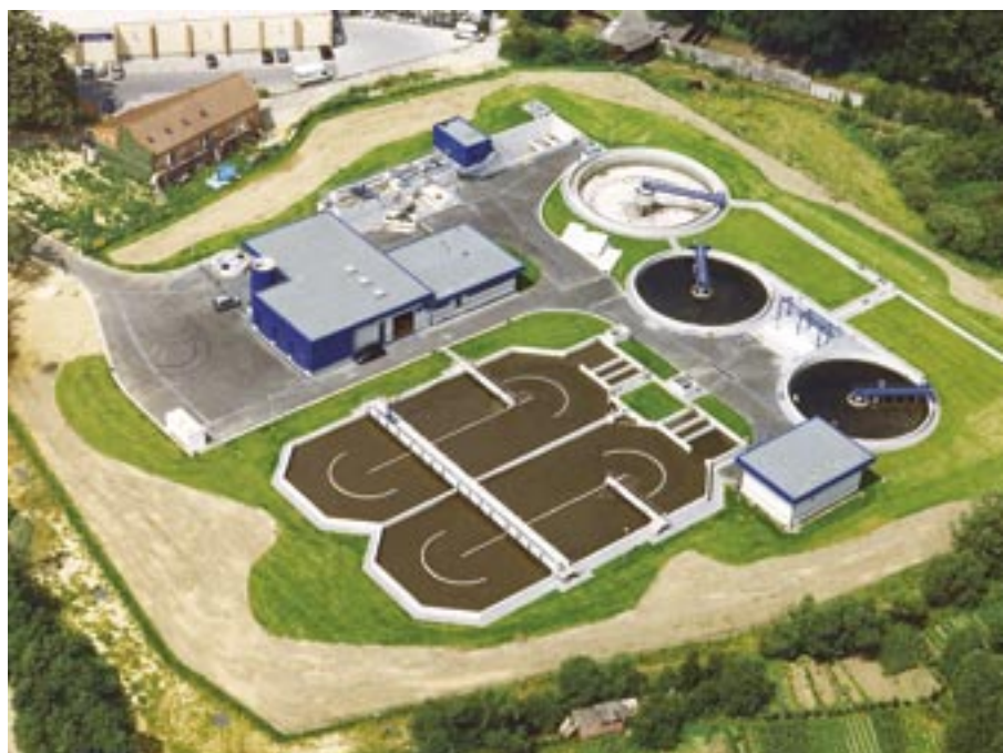
La station d'épuration de Tubize.
