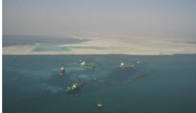
Dragage et remblayage de 1.700 ha pour la construction du nouvel aéroport international de Doha au Qatar.
