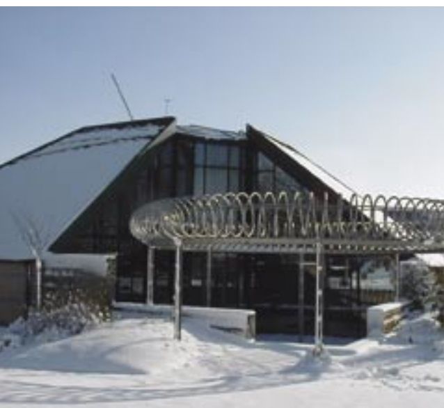
Le siège de l'entreprise Nizet et du magasin Voltis à Louvain-la-Neuve.
