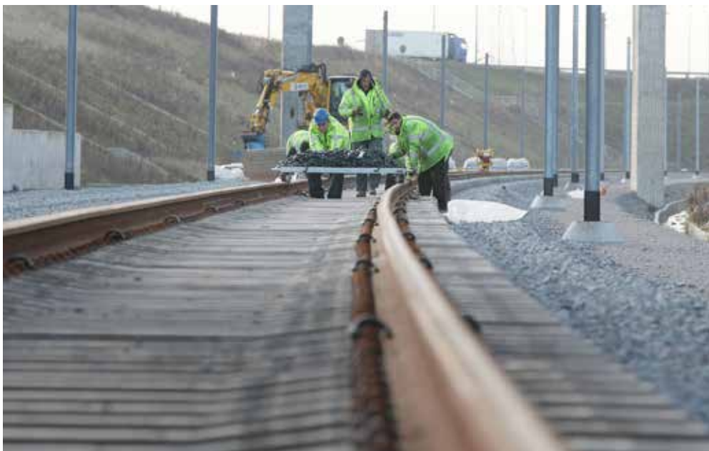
Pose de voies ferroviaires
