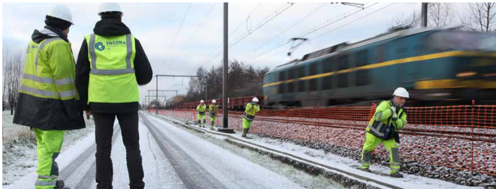
▲ Travaux de signalisation ferroviaire - Lokeren
