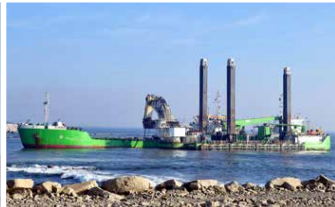
▲ Travaux de dragage - nouveau terminal méthanier de Cuyutlan (MEX)
