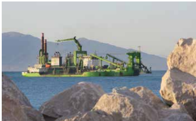
▲ Travaux de dragage - Tanger (MAR)
