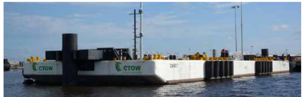
▲ Plate-forme de CTOW pour terminal GNL à Soyo - Angola
