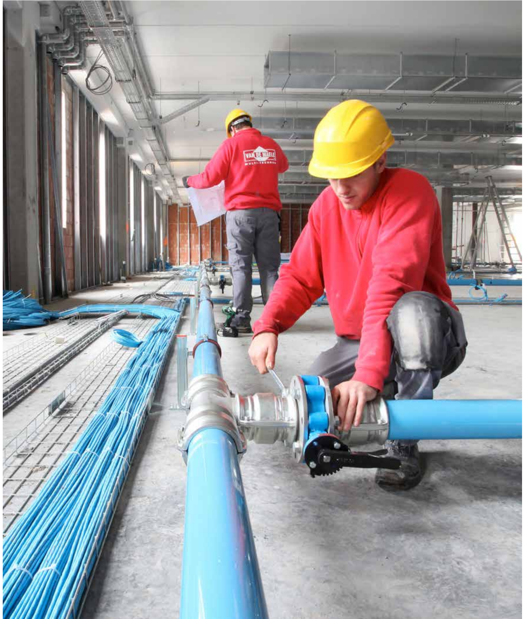
▲ Pose de canalisations d'air comprimé et sous vide - leper
