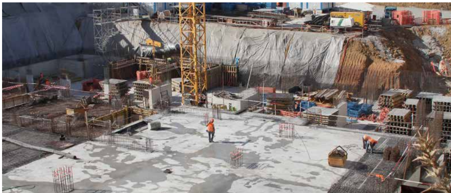
▲ Construction du siège BNP Paribas à Alger
