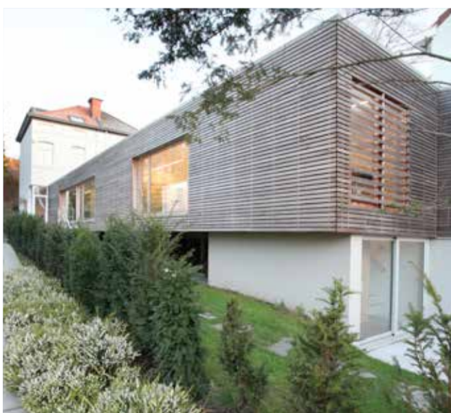
▲ Construction d'une galerie d'art et d'une piscine couverte en ossature bois - Bruxelles
