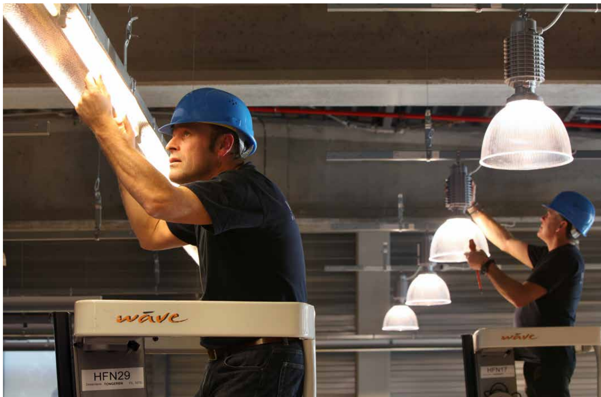
▲ Travaux d'électricité - Dreamland - Tongeren
