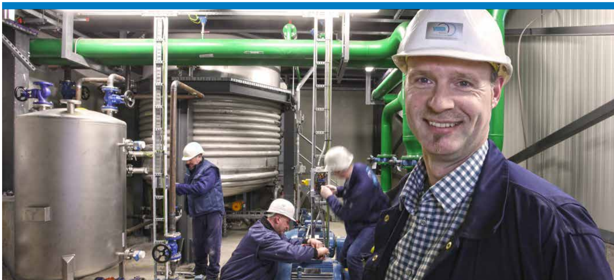
▲ Travaux électriques dans l'industrie chimique - Gand
