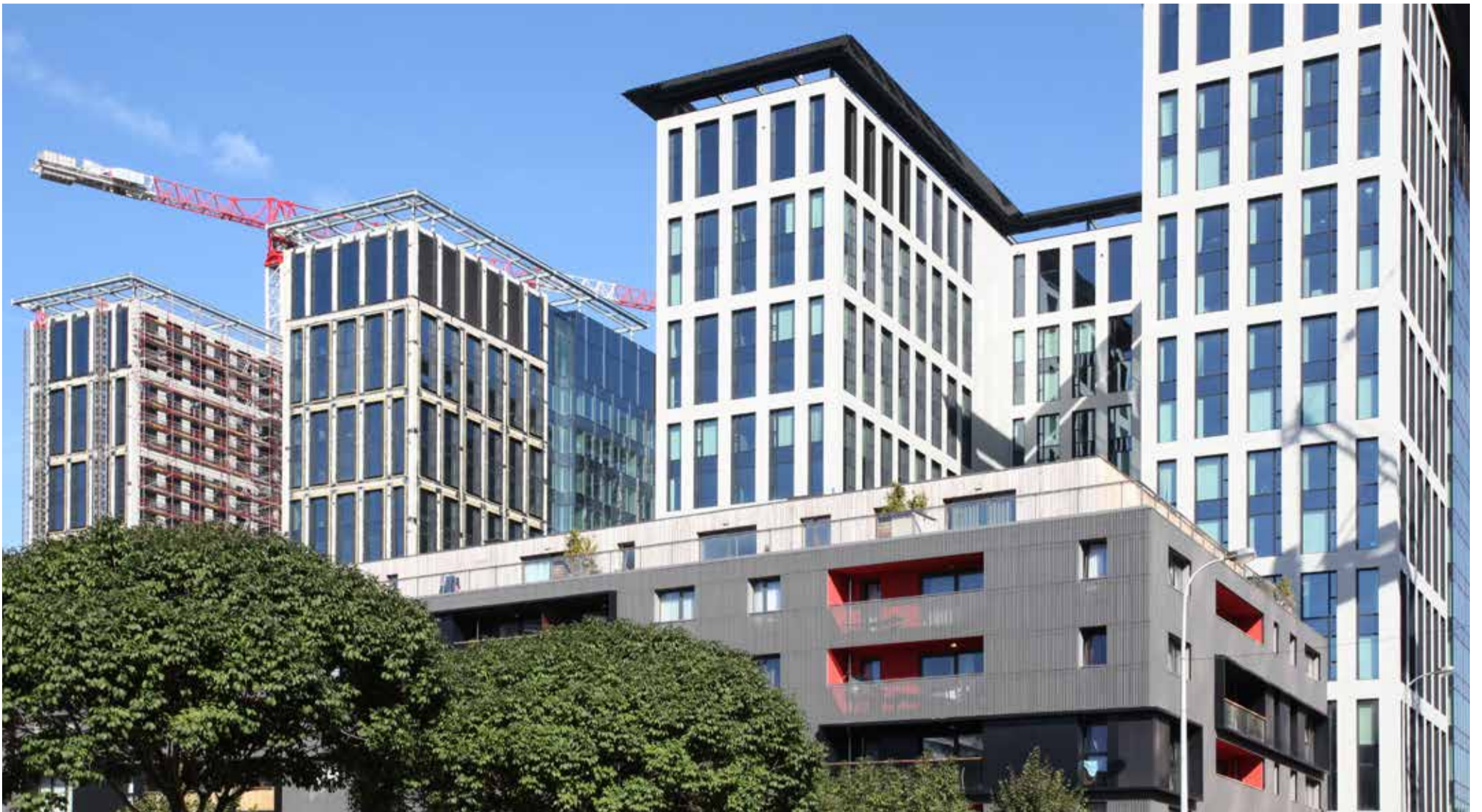
▲ Immeubles de bureaux Pole Star (à gauche) et North Light (à droite) - Bruxelles
