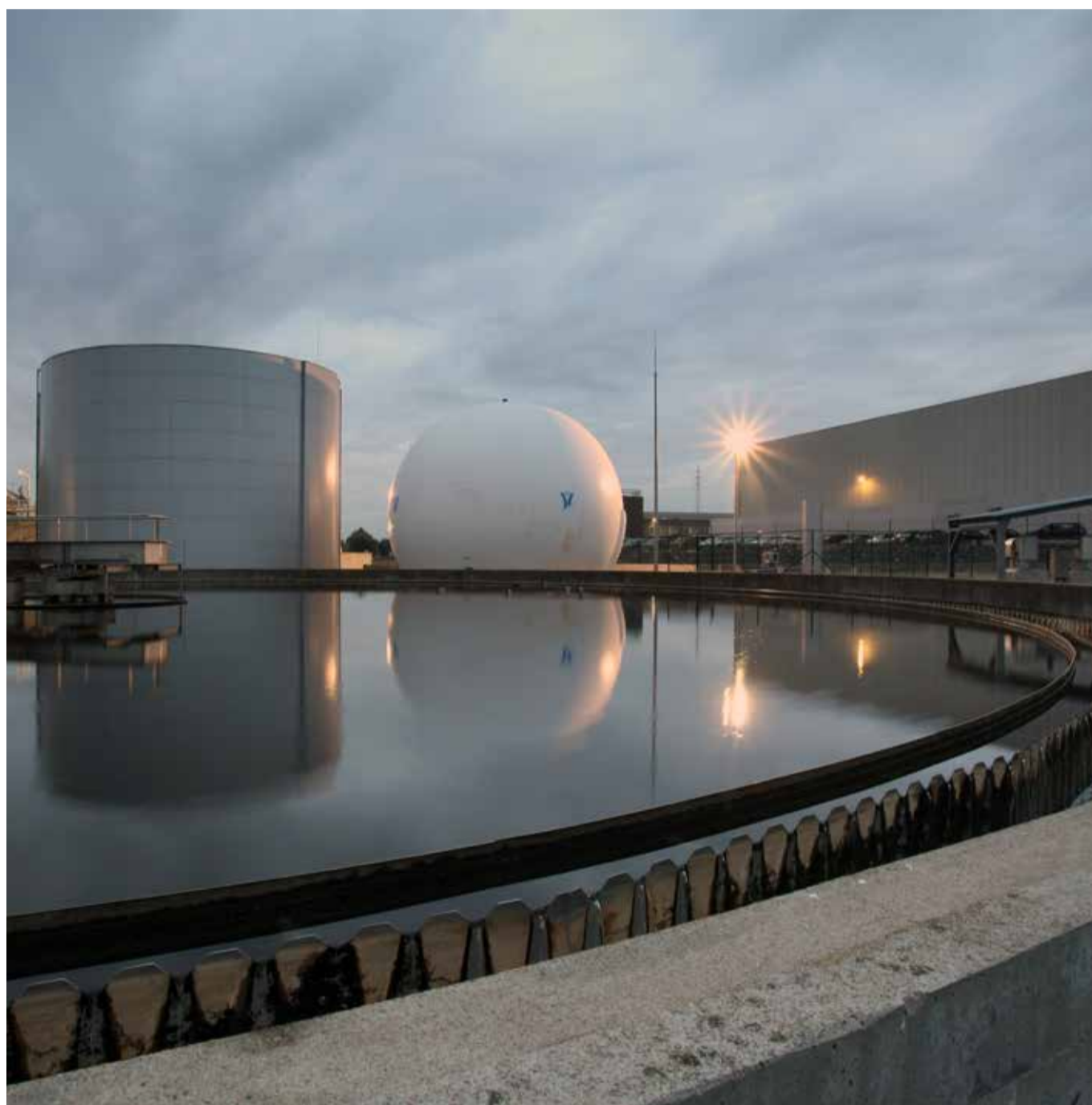
▲ Station d'épuration et réservoir de digestion de boues à Mouscron
