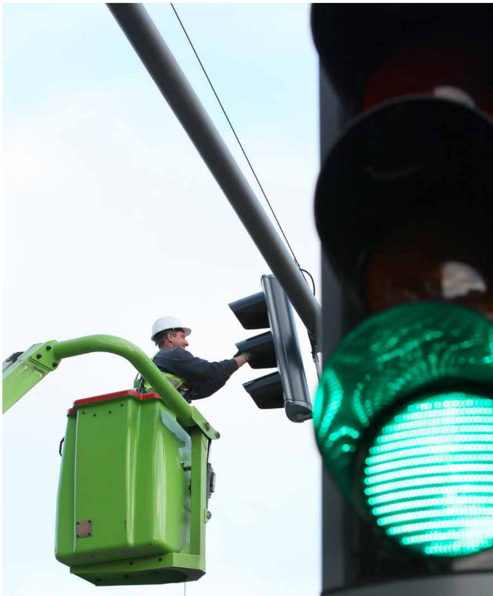
▲ Travaux d'éclairage public - Mons
