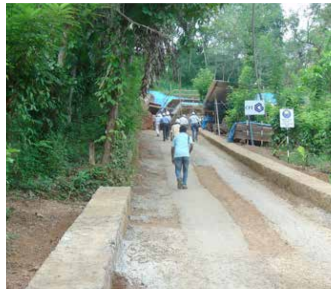
▲ Construction d'une station de potabilisation d'eau en montagne - Kolonna (LKA)
