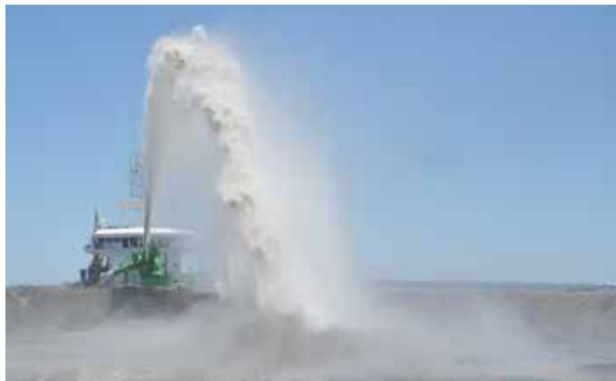
▲ Travaux de dragage - Montevideo (URY)
