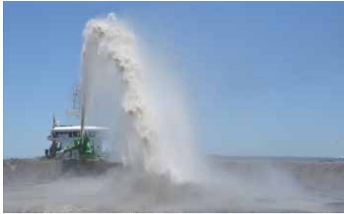
▲ Dredging works - Montevideo (URY)
