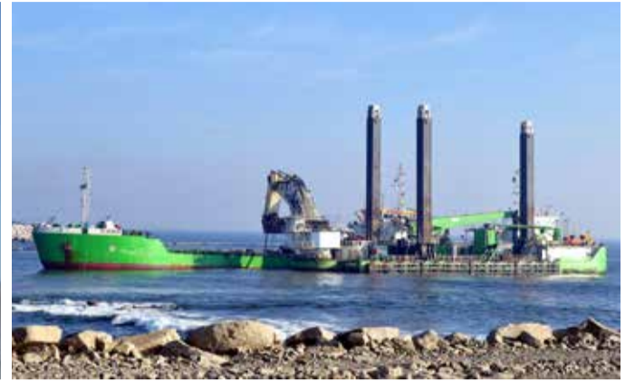
▲ Dredging works - new Cuyutlan LNG carrier terminal (MEX)
