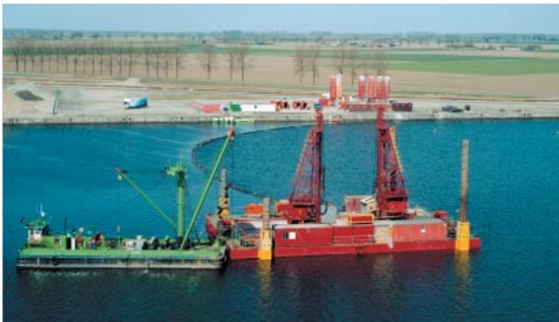
*HSS a utilisé sa technique brevetée de renforcement de sols mous pour construire les fondations d'une nouvelle digue en vue du remblai du Doeldok.*
