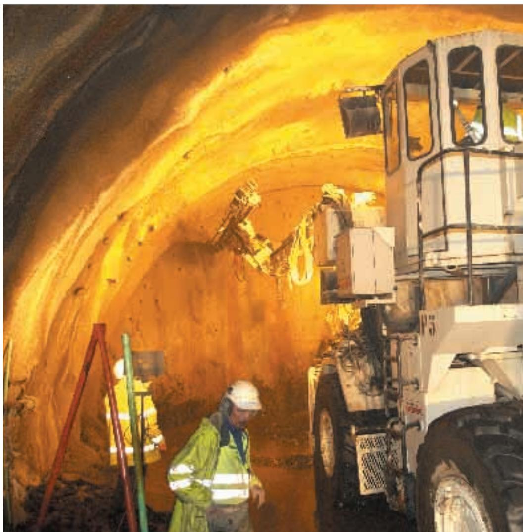
*Creusement à la dynamite du tunnel de Soumagne pour le tronçon entre Liège et la frontière allemande de la ligne ferroviaire à grande vitesse.*
