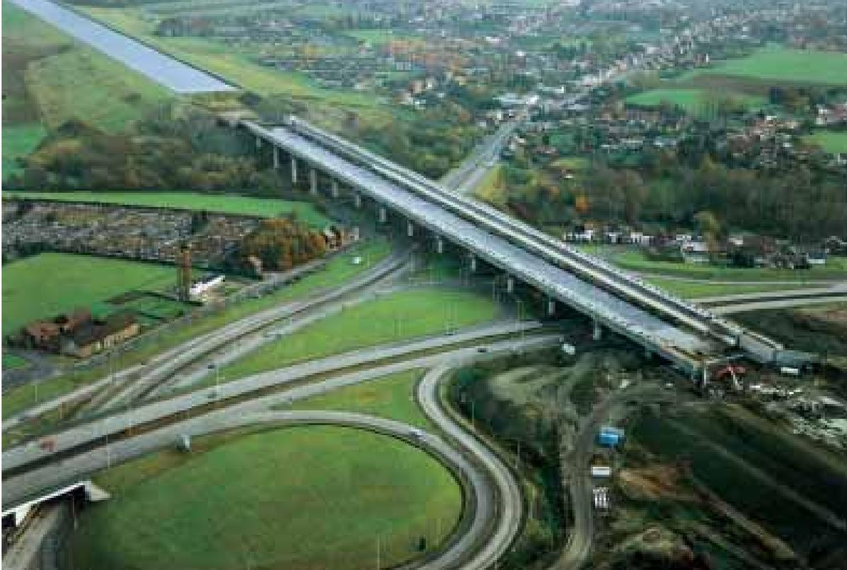
▲ Le pont-canal du Sart, réalisé par poussage à Houdeng-Aimeries (Belgique).
