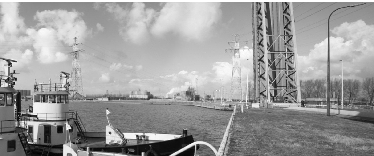
Le tunnel ferroviaire Liefkenshoek offrira des nouvelles perspectives de transport et de développement pour le Port d'Anvers.
