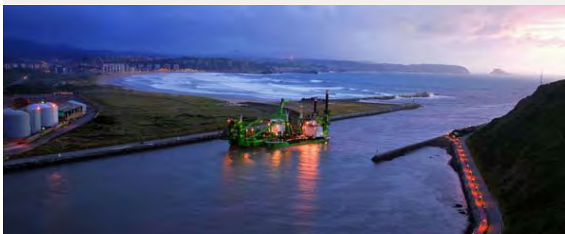
Approfondissement du chenal d'accès du Port d'Avilès (ESP)
