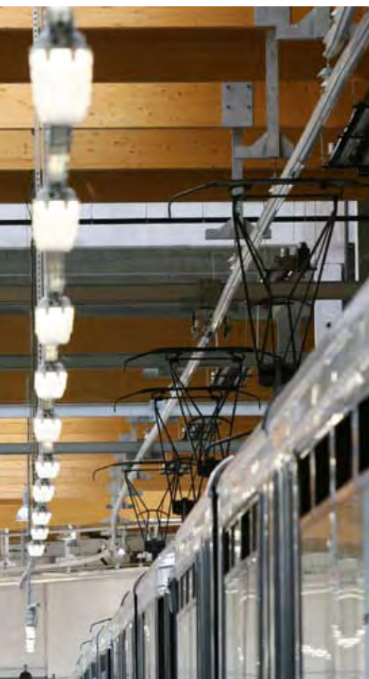
Installation des caténaires et travaux d'électricité du nouveau dépôt de trams | Haren (BE)
