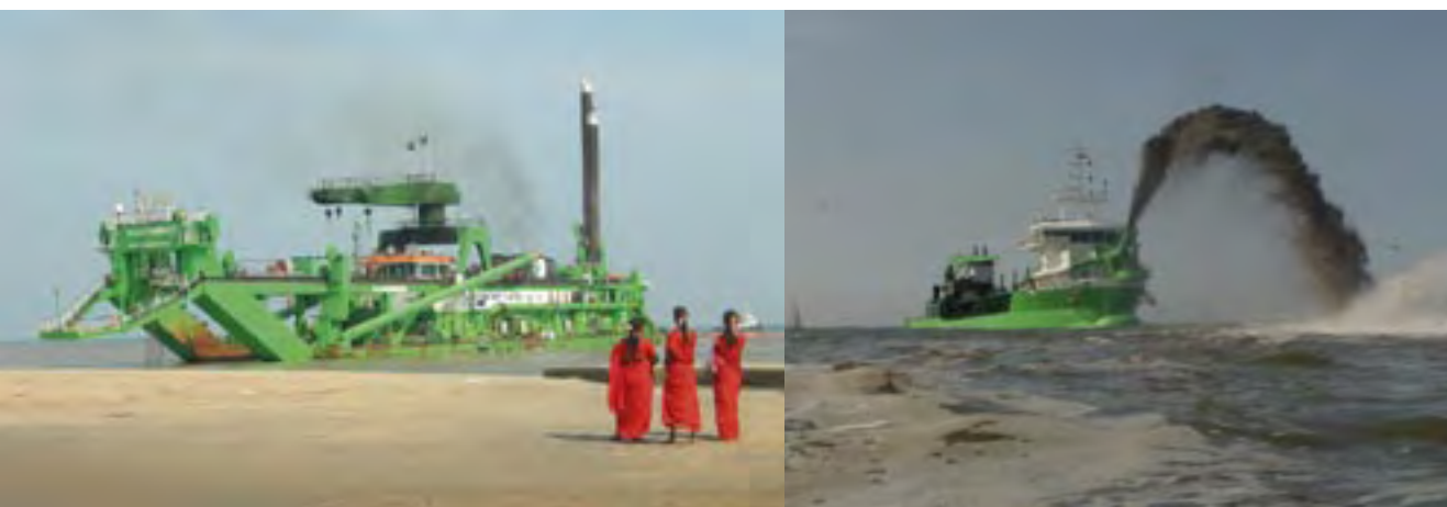
Dragage et refoulement à terre pour créer les remblais dans le cadre de la construction du nouveau port de Gangavaram en Inde.
