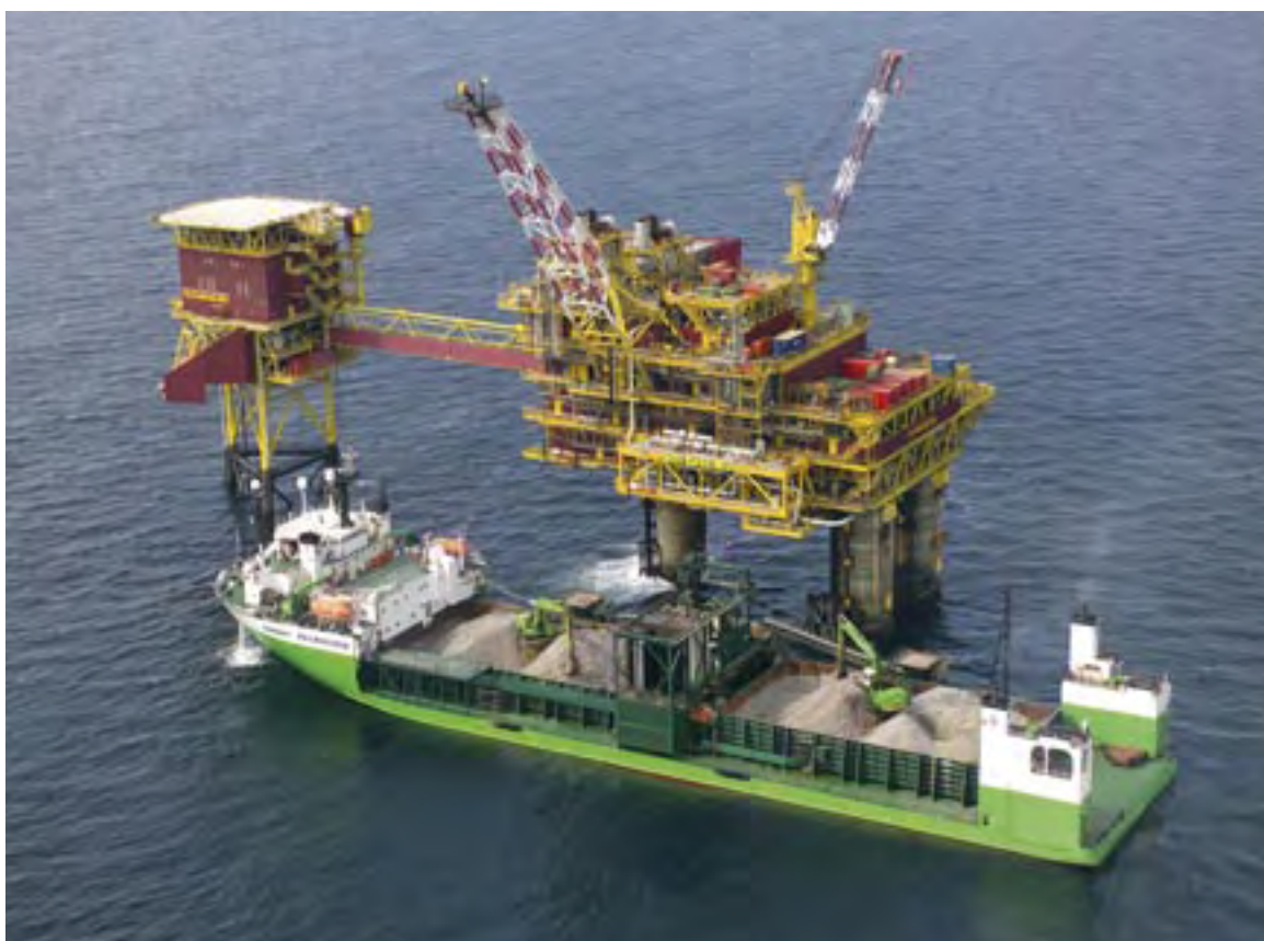
Déversement de roches en mer du Nord par le D.P. "Rollingstone".
