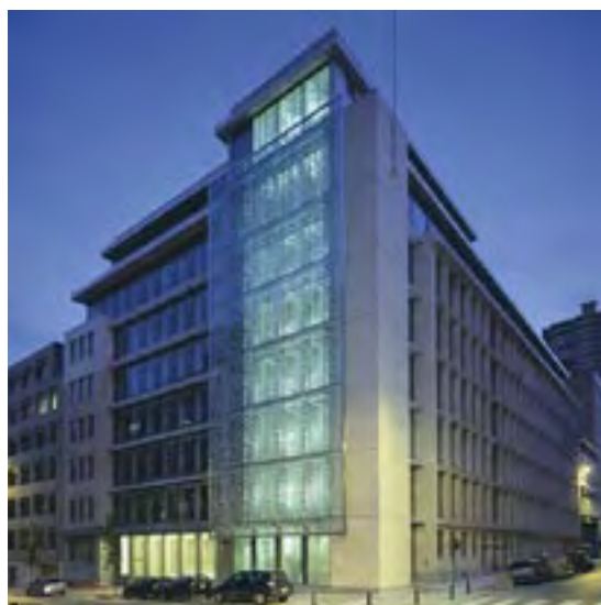
Immeuble "Montoyer" à Bruxelles Architecte: Assar - Mr. Ysebrant et Mr. Morales.
