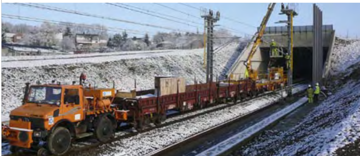
Pose de caténaires par Engema Rail sur la ligne TGV Liège - Cologne.
