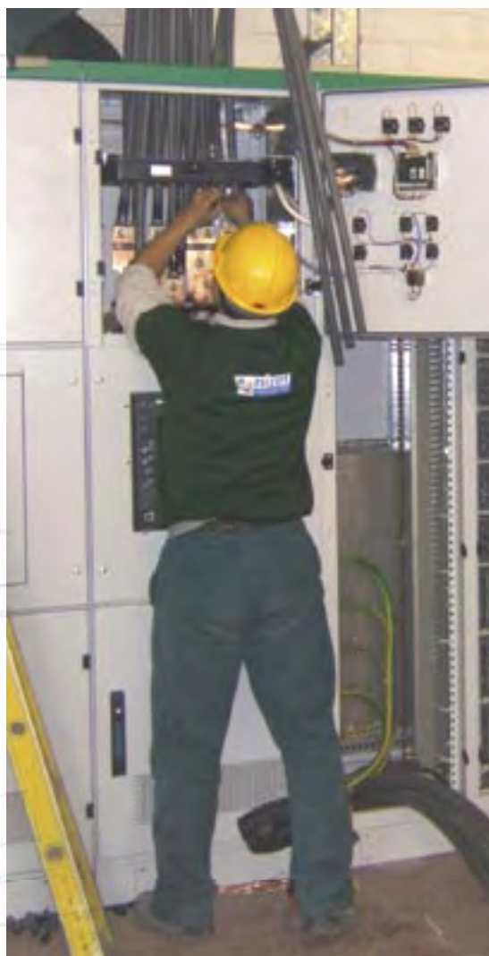
Raccordement des tableaux pour le reconditionnement de la station d'épuration de Roselies. Bureau d'études: IGRETEC.
