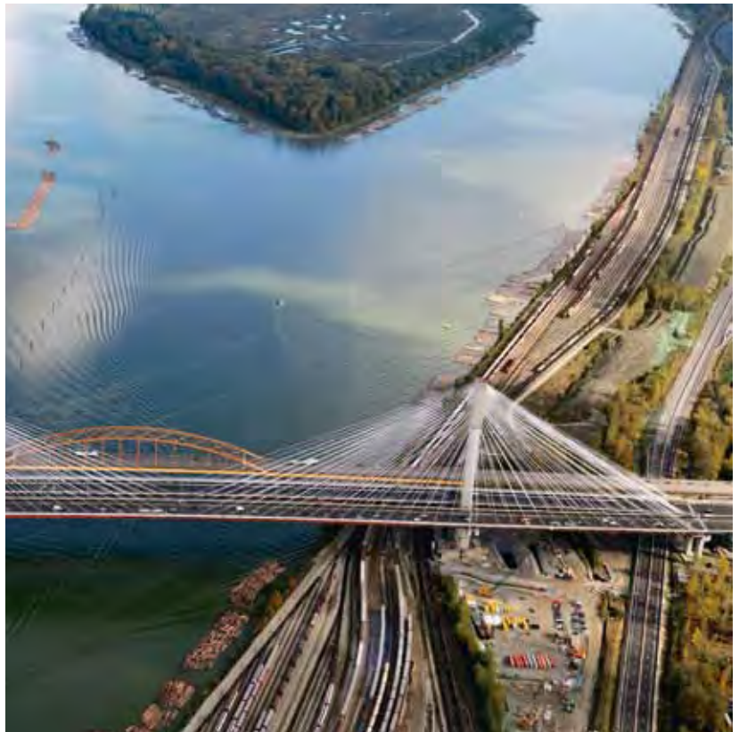
PUENTE DE PORT MANN (CANADÁ)
