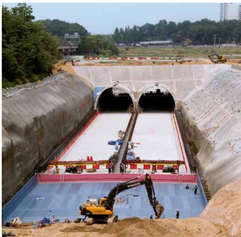
AUTOVÍA SUWON KWANGMYEONG (SKM) (COREA DEL SUR) UN TÚNEL DE 2,6 KM EN TECHSPAN®
