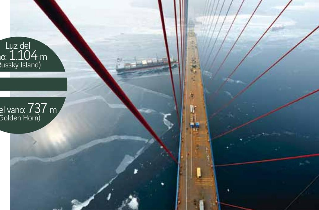
« El puente de Russky Island: récord del mundo por la luz del vano en una construcción atirantada. »
