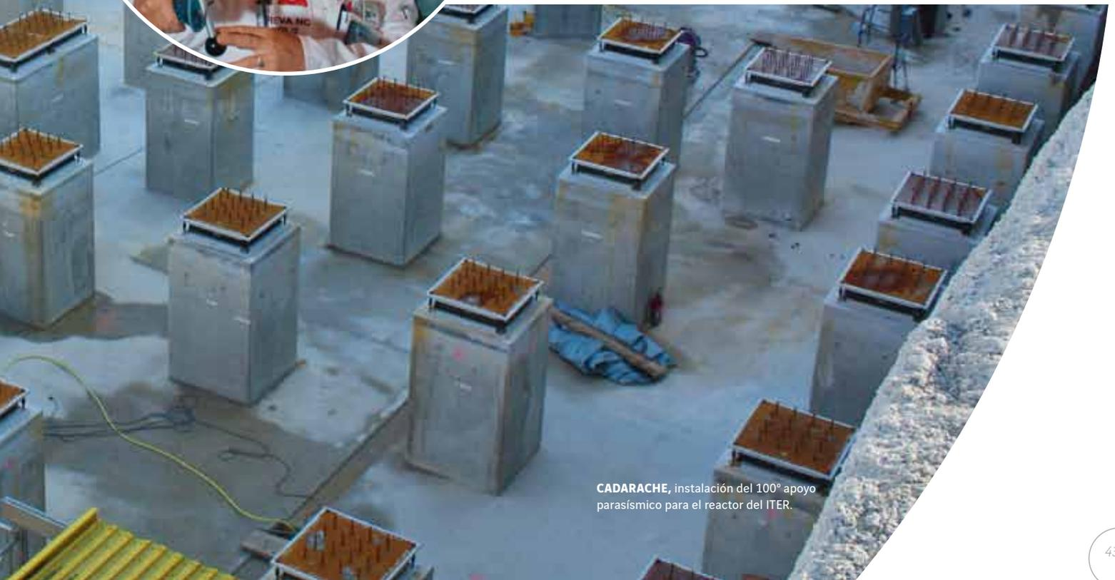
**CADARACHE, instalación del 100º apoyo parasísmico para el reactor del ITER.**
