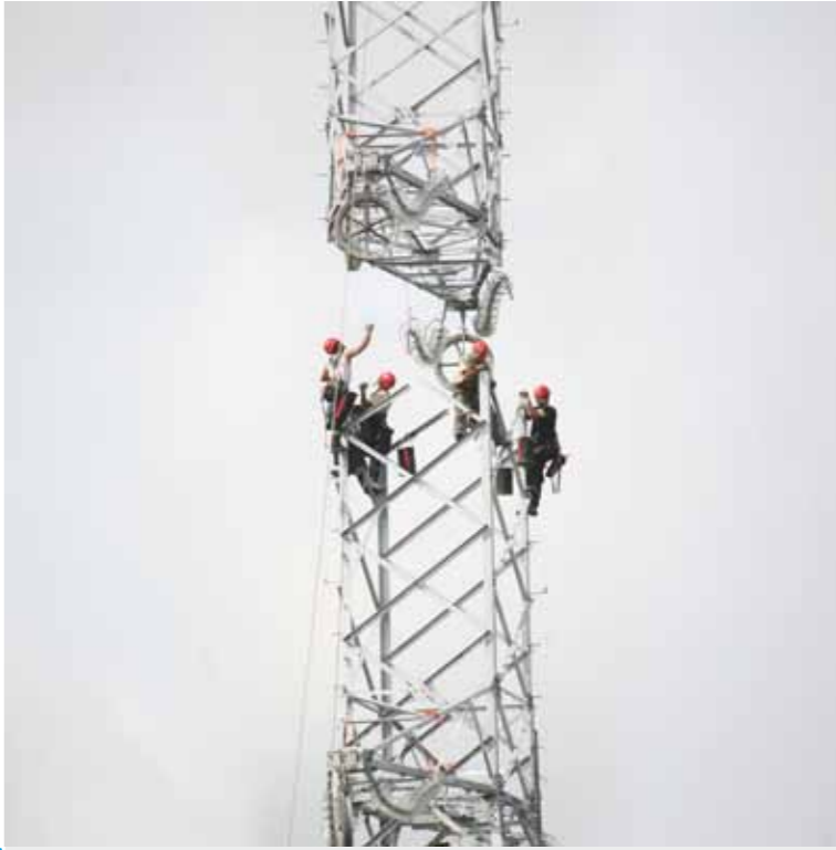
Installation of a high tension pylon - Tergnée - Farcienne - Pont de Loup (BE)
