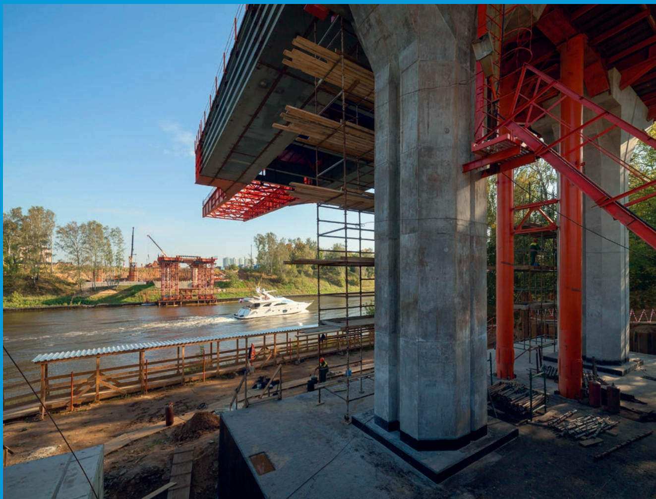
La construction du nouveau tronçon de la M11 : un défi logistique.
