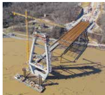
Le projet de l'Ohio East End Crossing inclut la construction d'un pont haubané de 762 m franchissant la rivière Ohio au nord-ouest de Louisville.
