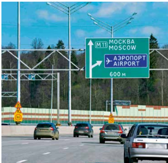
Reliant notamment le périphérique moscovite à l'aéroport international de Cheremetievo, la nouvelle infrastructure fluidifie le trafic dans une zone totalement saturée.
