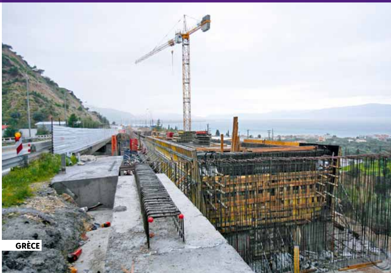
Travaux sur l'autoroute Olympia-Odos (Grèce).
