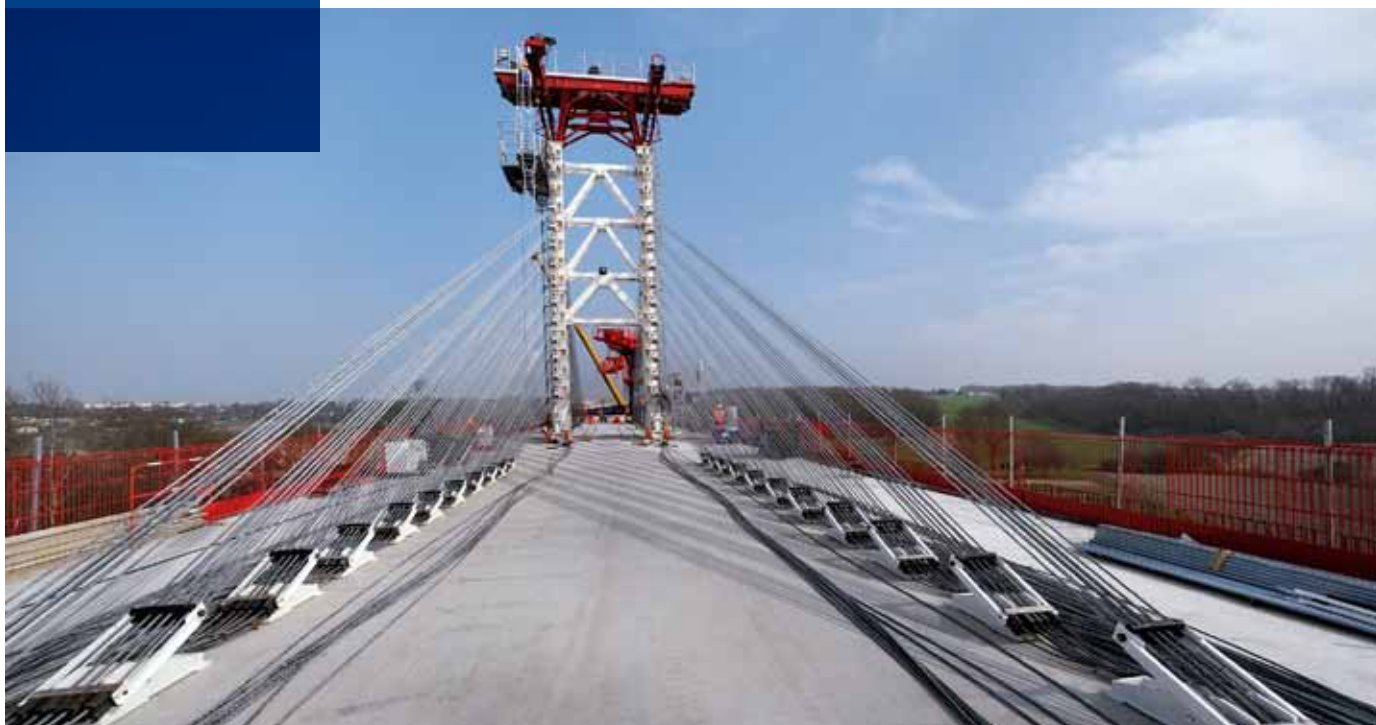
Construction du viaduc de la Boème, LGV SEA Tours-Bordeaux (France).
