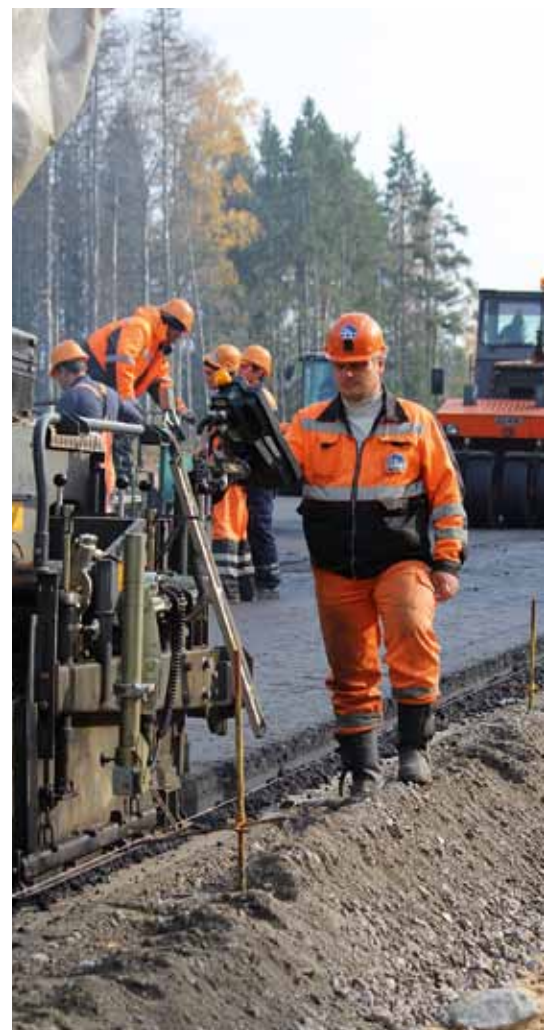
Travaux sur le projet d'autoroute Moscou - Saint-Petersbourg (Russie).
