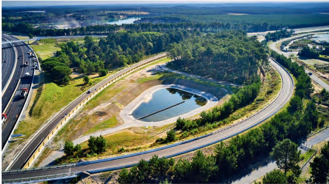
*Bassin de collecte et de traitement des eaux de ruissellement de l'autoroute, à Saint-Geours-de-Maremne (Landes), réalisé dans le cadre de l'élargissement et du réaménagement de l'A63.*
