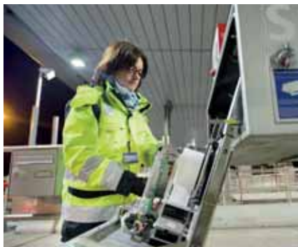
1 – La maintenance des équipements techniques est l'une des missions exercées par les salariés de la filière péage.
