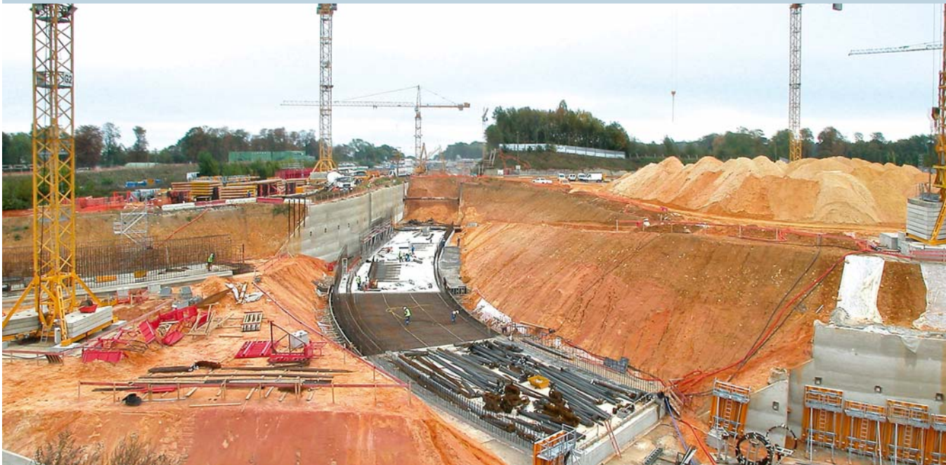
Echangeur A13 - Bretelle d'accès
