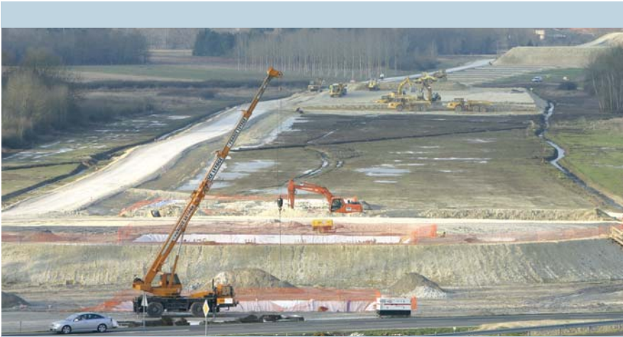
Travaux sur l'A85 au niveau de la traversée de la vallée du Cher
