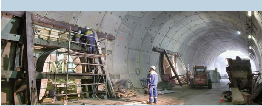
Tunnel Est 1 Construction d'une niche de désenfumage
