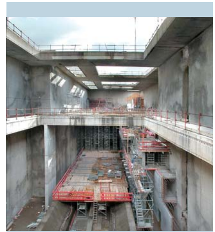
Construction du prolongement de la dalle inférieure du tunnel au niveau de l'échangeur A13
