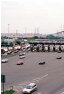
> Dartford toll barrier (England)
