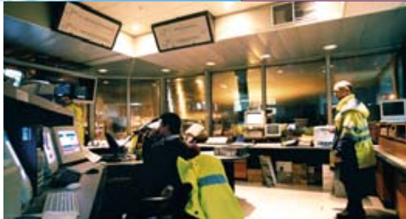
> Local de surveillance de la barrière de Saint-Armout-en-Yvelines
