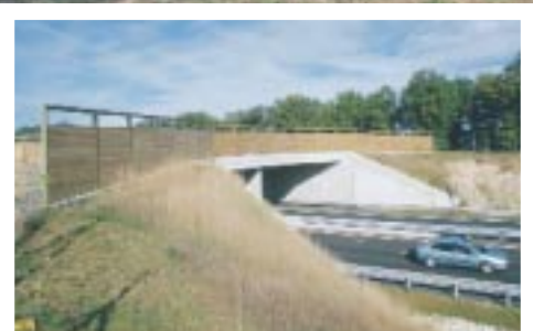
Passage grande faune sur l'A85.
