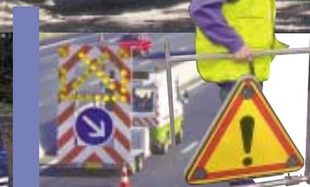
*Les flèches lumineuses de rabattement renforcent la sécurité lors de la plupart des chantiers de courte durée sur les voies de circulation.*
