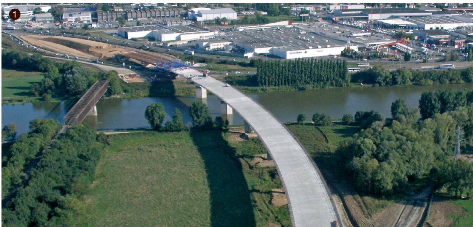
1 Construction du viaduc de la Maine - A11 Angers
