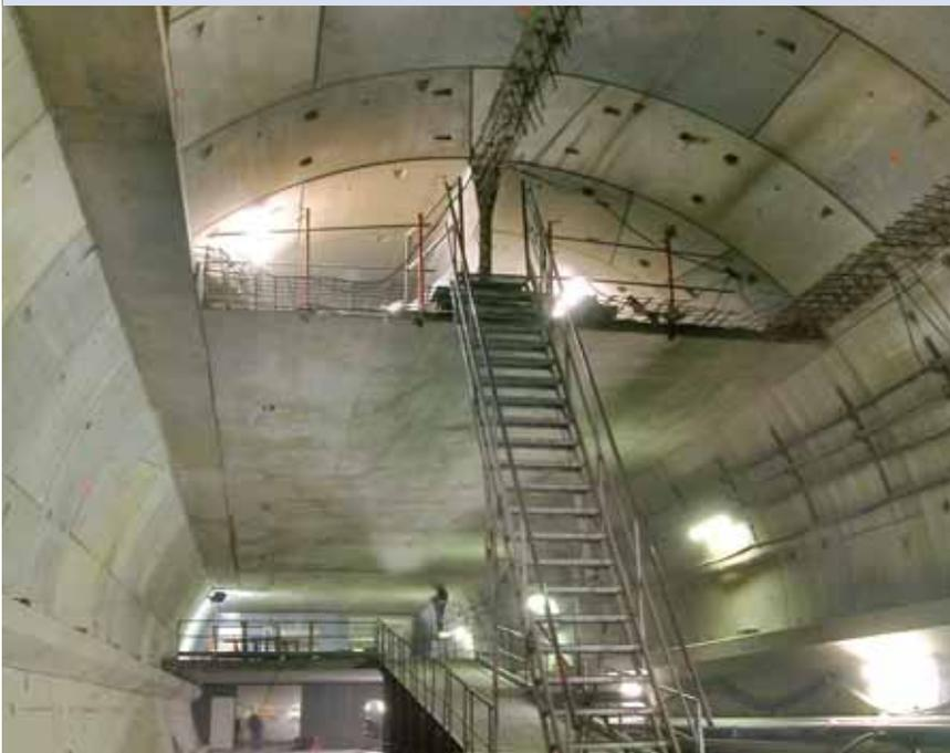
Puits de secours et unité de ventilation au long de la RD10 (Viroflay)
