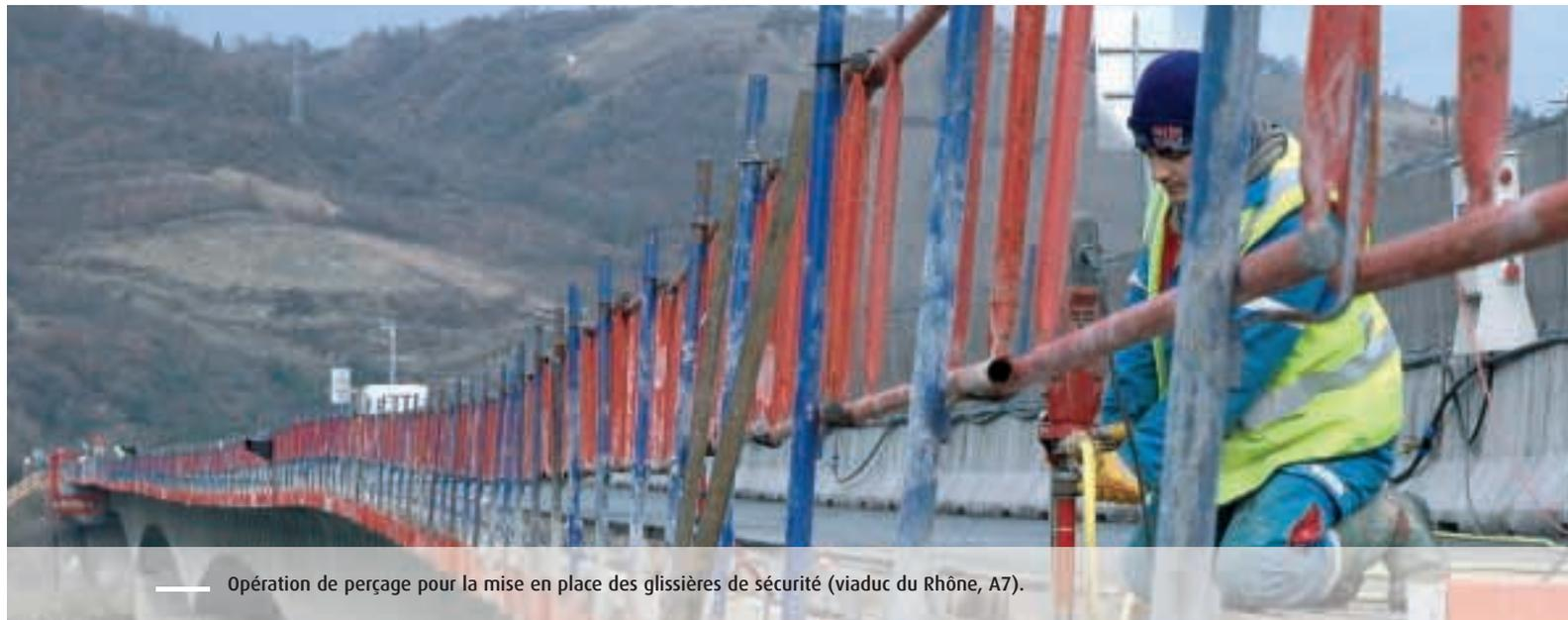
Opération de perçage pour la mise en place des glissières de sécurité (viaduc du Rhône, A7).
