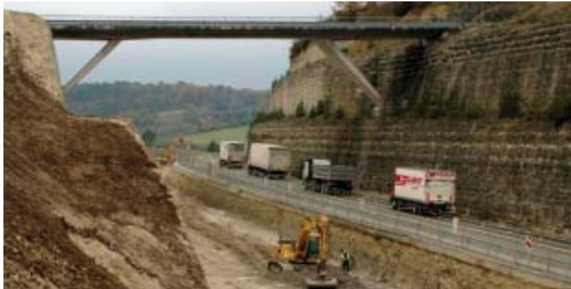
A89. Périgueux-Ouest/Périgueux-Est section: crossing the Col du Rolet
