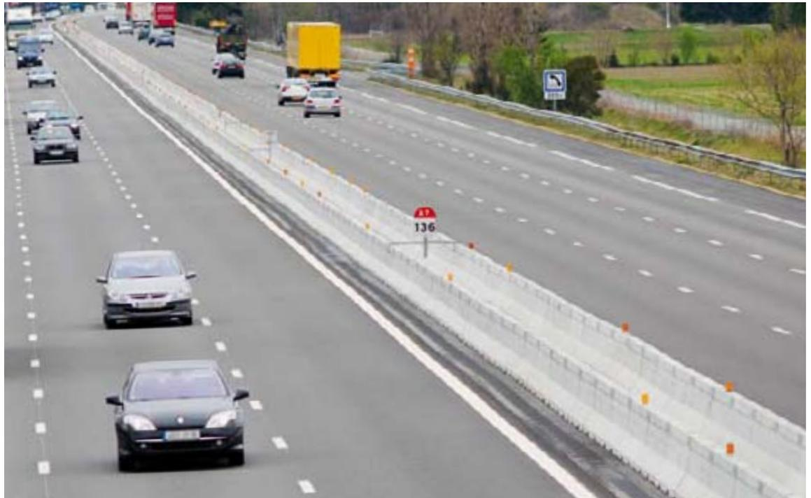
Sur l'autoroute A7, un terre-plein central, constitué de séparateurs modulaires de voie en béton. Ce système plus sûr permet la mise en place de chantiers mobiles tout en assurant un meilleur niveau de sécurité.
