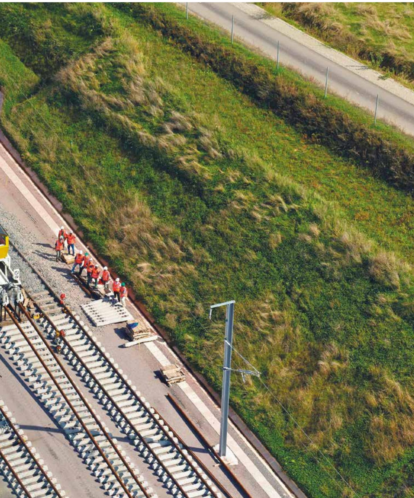
traverses en béton et LRS, dont la longueur peut atteindre jusqu'à 434 m. Pour ce projet, ETF a développé une méthode et un outil de pose spécifique. Ce wagon, associé à une nouvelle remorque de pose de traverses en béton, extrait les rails de la rame de stockage et les met en place par poussage sur des rouleaux ancrés sur les traverses. La voie neuve est ainsi directement installée par tronçons de 400 m, ce qui génère des gains en termes
