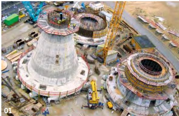
**01** Les piles de fondation en béton précontraint des six premières éoliennes du parc *off-shore* du Thorntonbank ont été mises en chantier en 2007 dans le port d'Ostende (Belgique).
