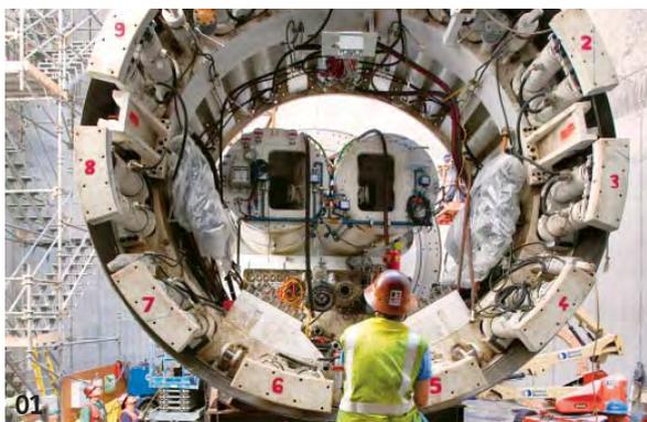
**01** Mise en place d'un élément de tunnelier dans le puits d'accès du chantier du réseau d'eau potable de Bridgewater à Seattle (États-Unis).
