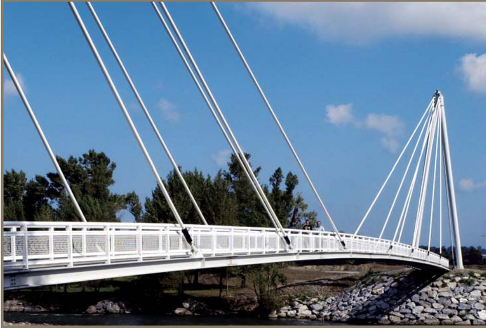
Freyssinet a reçu en 2003 le premier prix de l'innovation de la FNTP pour les câbles en fibres de carbone. Mis en œuvre sur la passerelle de Laroin, en France, ils contribuent à améliorer la durabilité des structures.
